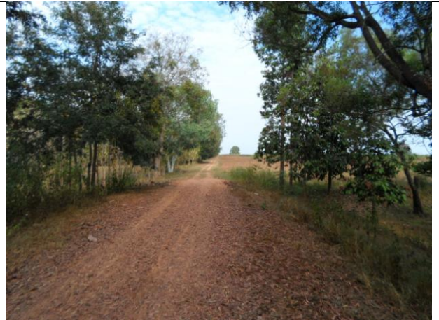
由周邊道路的落差發現逕流水可能未全部導入排水溝中
