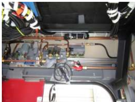
圖 3-73 車內通道門配管檢查
