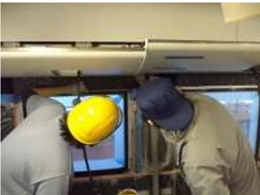
圖 3-81 行李架安裝檢查
