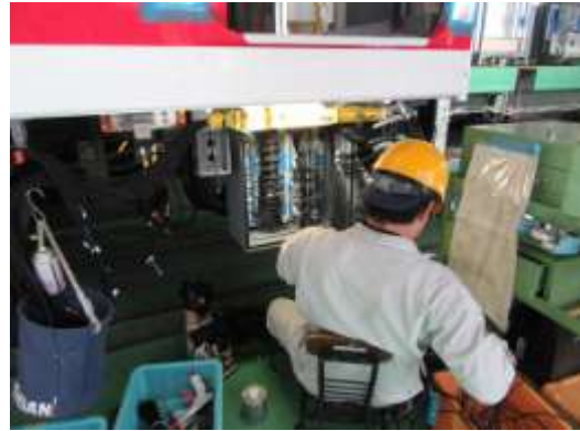
圖 3-92 車下配線檢查-2
