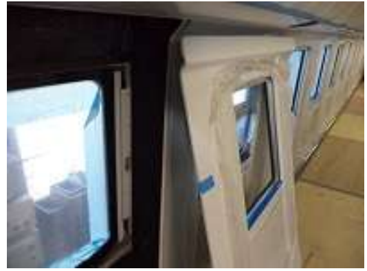
圖 3-78 車內側板安裝檢查
