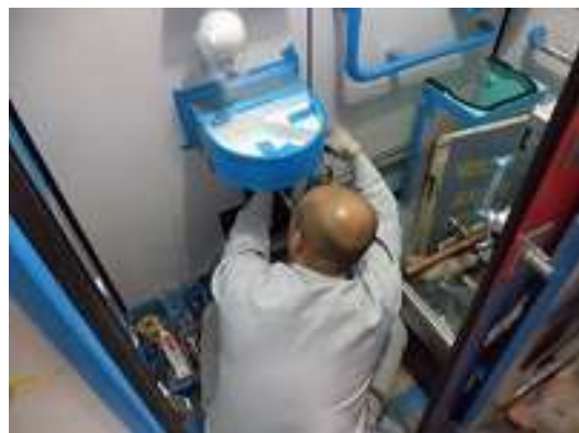
圖 3-74 廁所配管檢查
