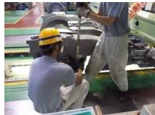
圖 3-50 螺栓鬆弛鎖緊作業
