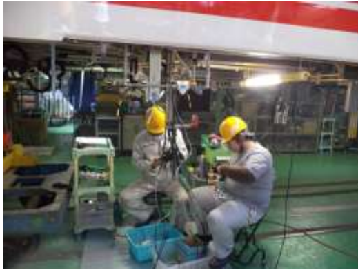
圖 3-91 車下配線檢查-1
