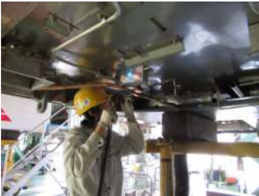
圖 3-85 車下配管焊接檢查
