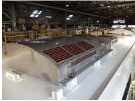
圖 3-100 車頂空調機檢查
