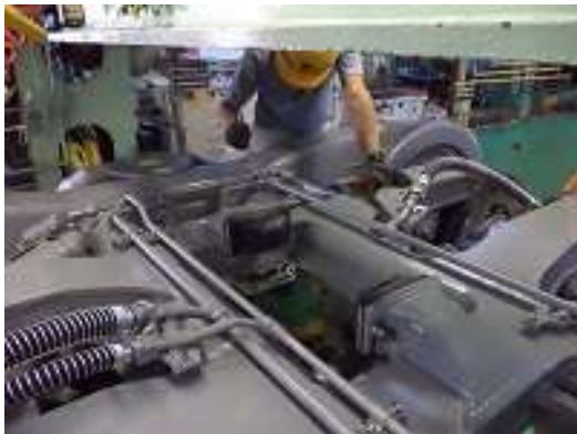
圖 3-53 配管壓力洩漏檢查
