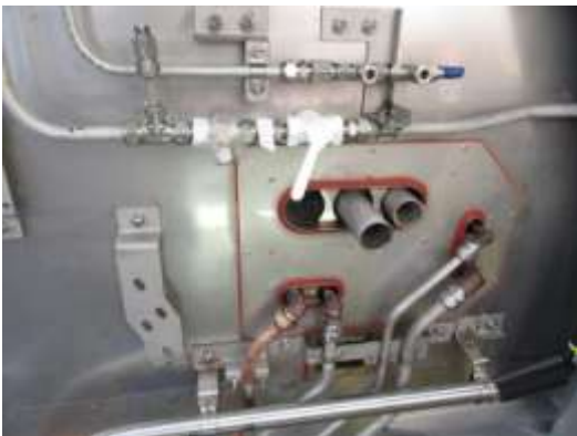
圖 3-89 車下配管檢查-4
