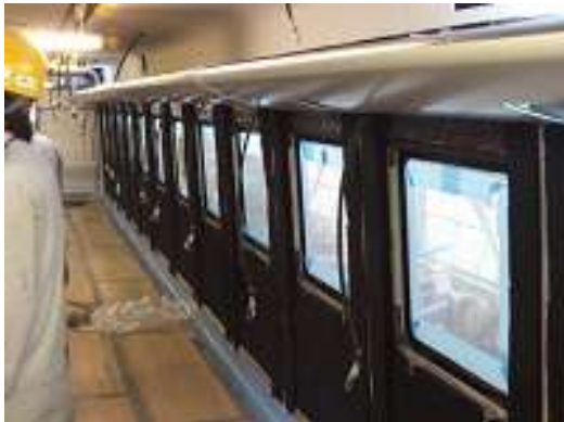
圖 3-61 車內內裝隔熱棉檢查
