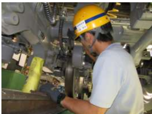
圖 5-14 軔機洩漏檢查
