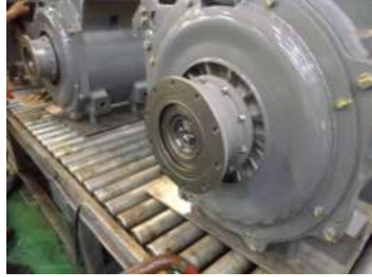
圖 3-36 馬達撓性接頭安裝檢查
