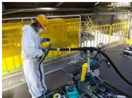
圖 3-96 車下高壓電纜線施工
