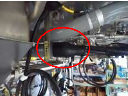
圖 3-93 管線末端封管作業檢查
