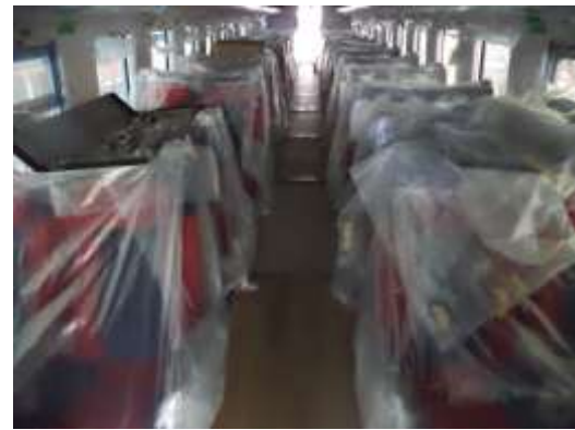
圖 3-102 座椅安裝檢查
