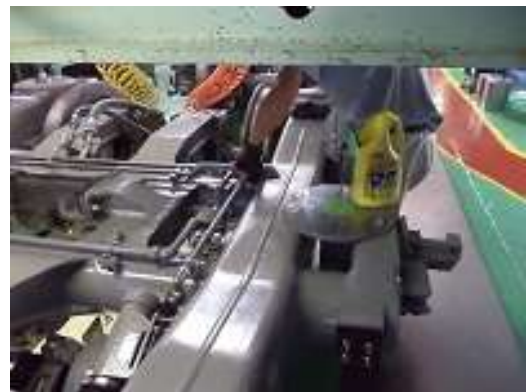
圖 3-54 配管洩漏檢查後配管拭淨
