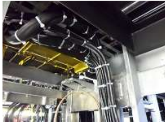
圖 3-68 車內配線檢查-4
