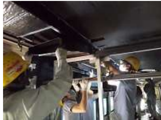
圖 3-62 車內風道安裝檢查
