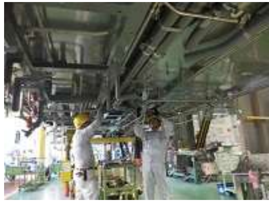
圖 3-86 車下配管檢查-1
