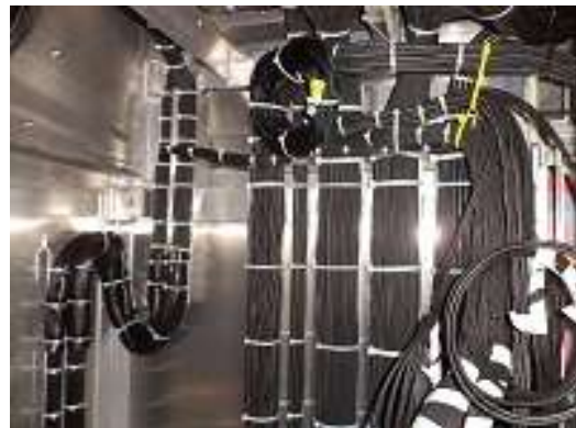
圖 3-66 車內配線檢查-2
