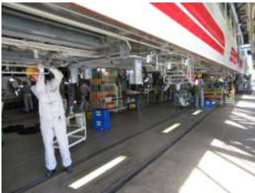
圖 3-87 車下配管檢查-2
