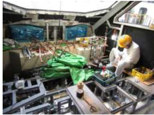
圖 3-72 駕駛室配管檢查
