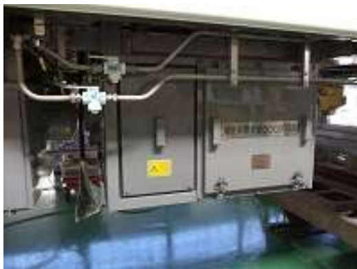
圖 3-95 增速風泵檢查
