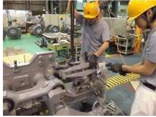
圖 3-20 軋機機構安裝
