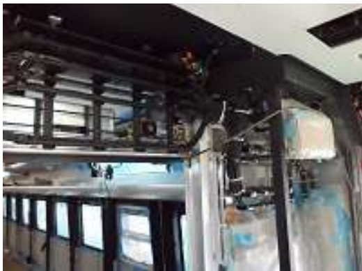
圖 3-65 車內配線檢查-1
