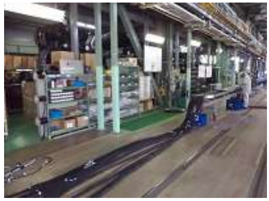
圖 3-90 車下線槽安裝檢查
