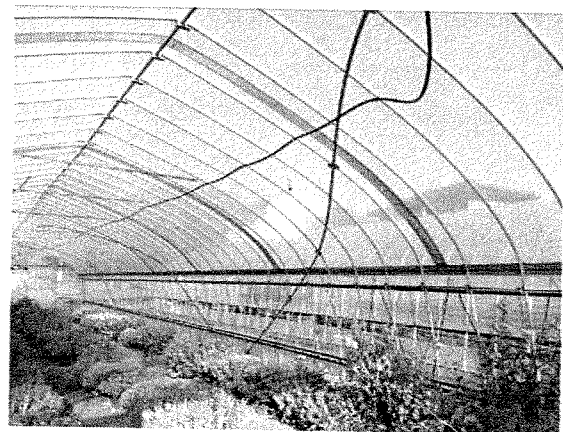
捲揚式溫網室，縮短鋁管間距，並以長方型鋁管作傾斜固定，以加強設施強度。
