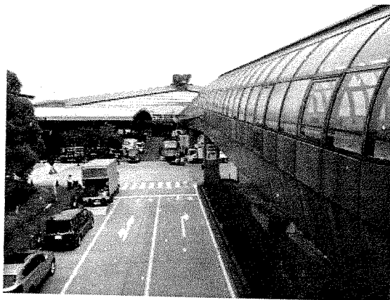
主建築間建有遮雨並架高之聯絡通道，利於工作人員及運輸工具移動。市場屋頂及周遭充分利用規劃停車位，以解決相關人員大量的停車需求。
