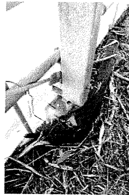
沖繩地區簡易溫網室基座以水泥樁進行固定及補強。
