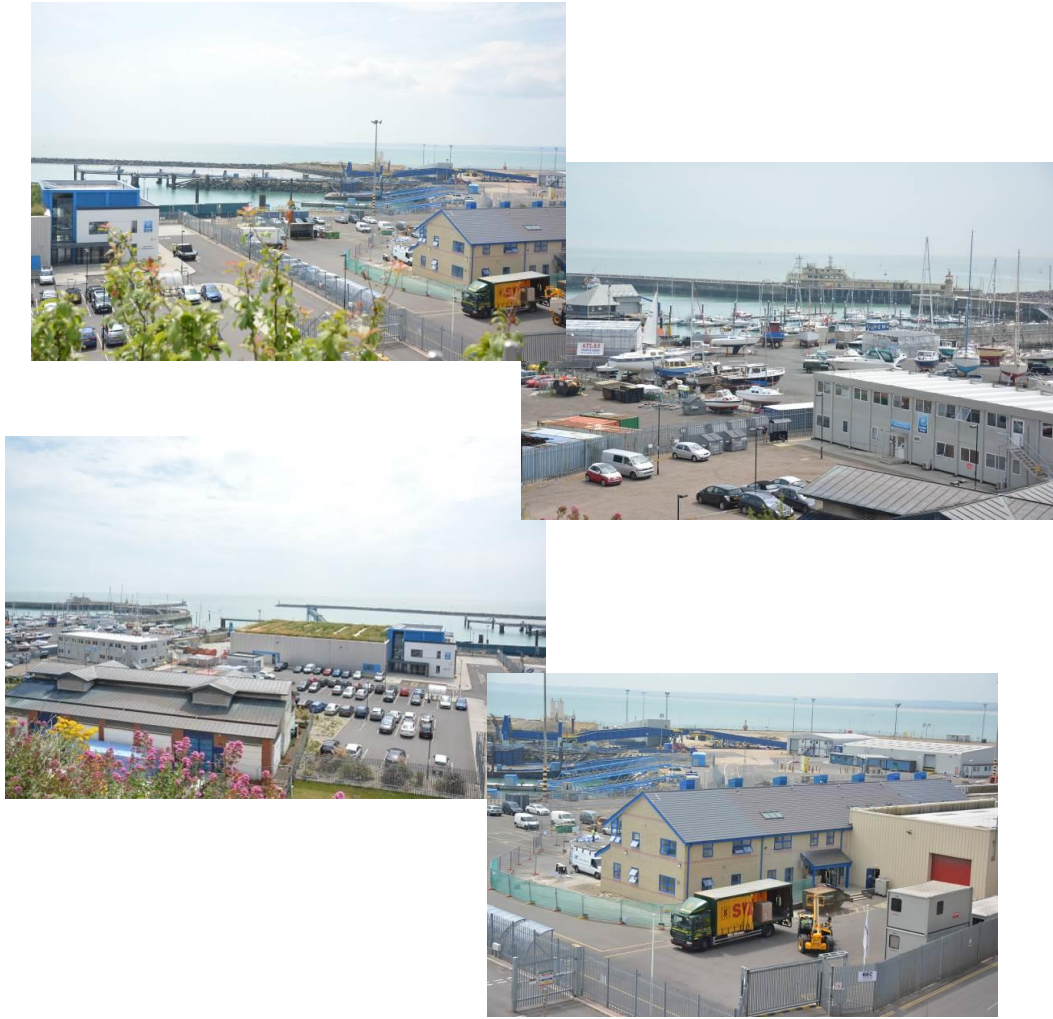
圖 10 Ramsgate Port 周邊設施現場拍攝
