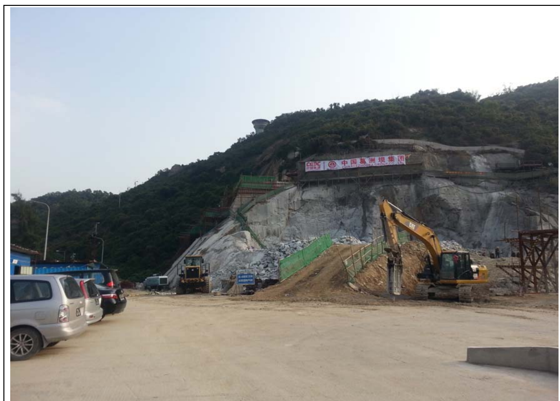
圖 5 -4 路環-九澳隧道北洞口施工現場
