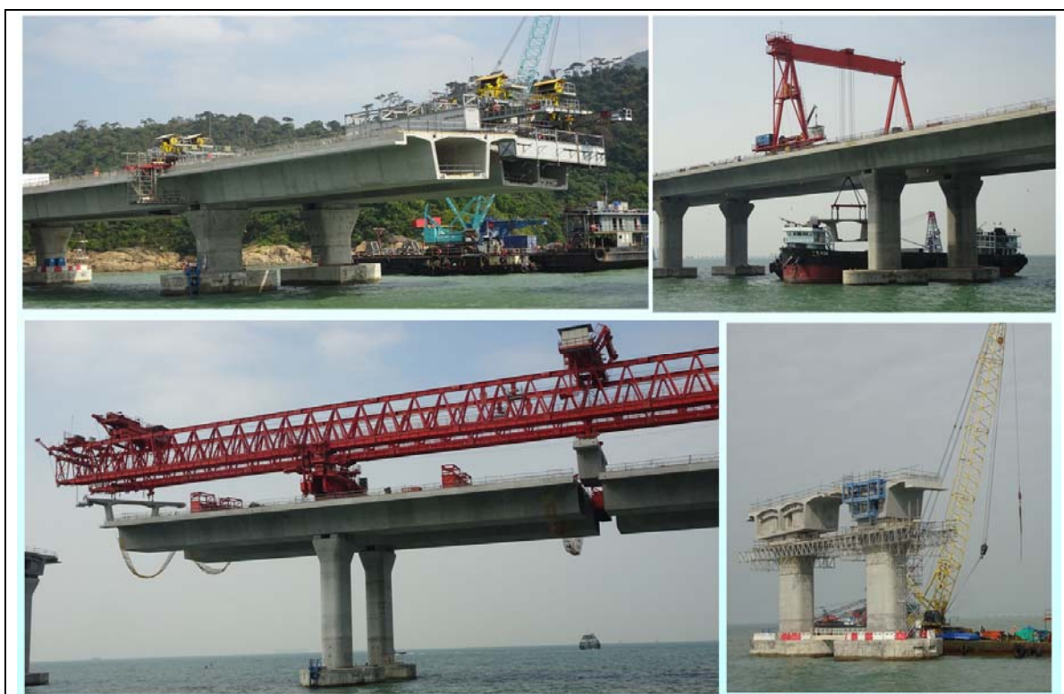
圖 4-15 香港連接線-跨海段上部結構施工
