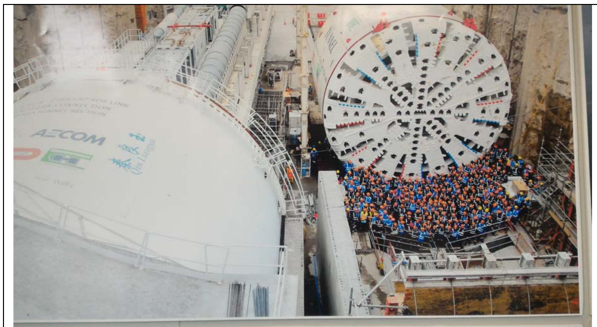
圖 4-21 屯門至赤鱸角連接路工程引進全球最大型直徑 17.6m 隧道鑽挖機
