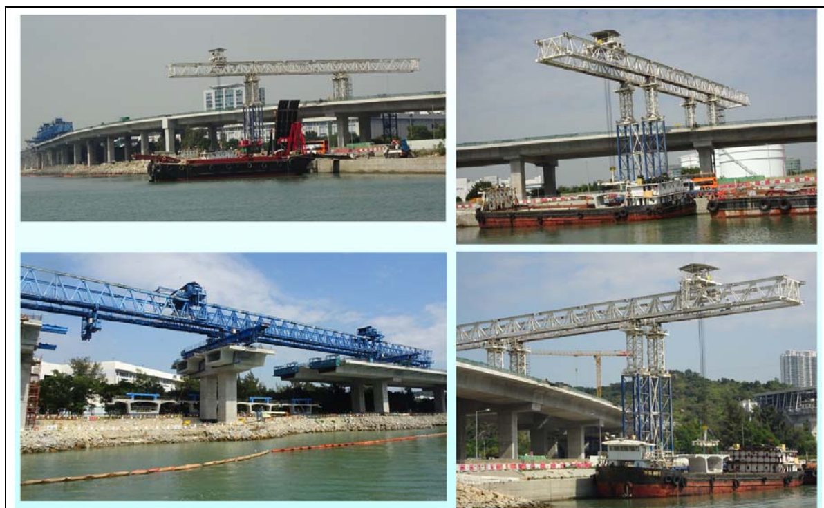
圖 4-8 香港連接線-沿赤鱸角機場段橋梁施工(2)
