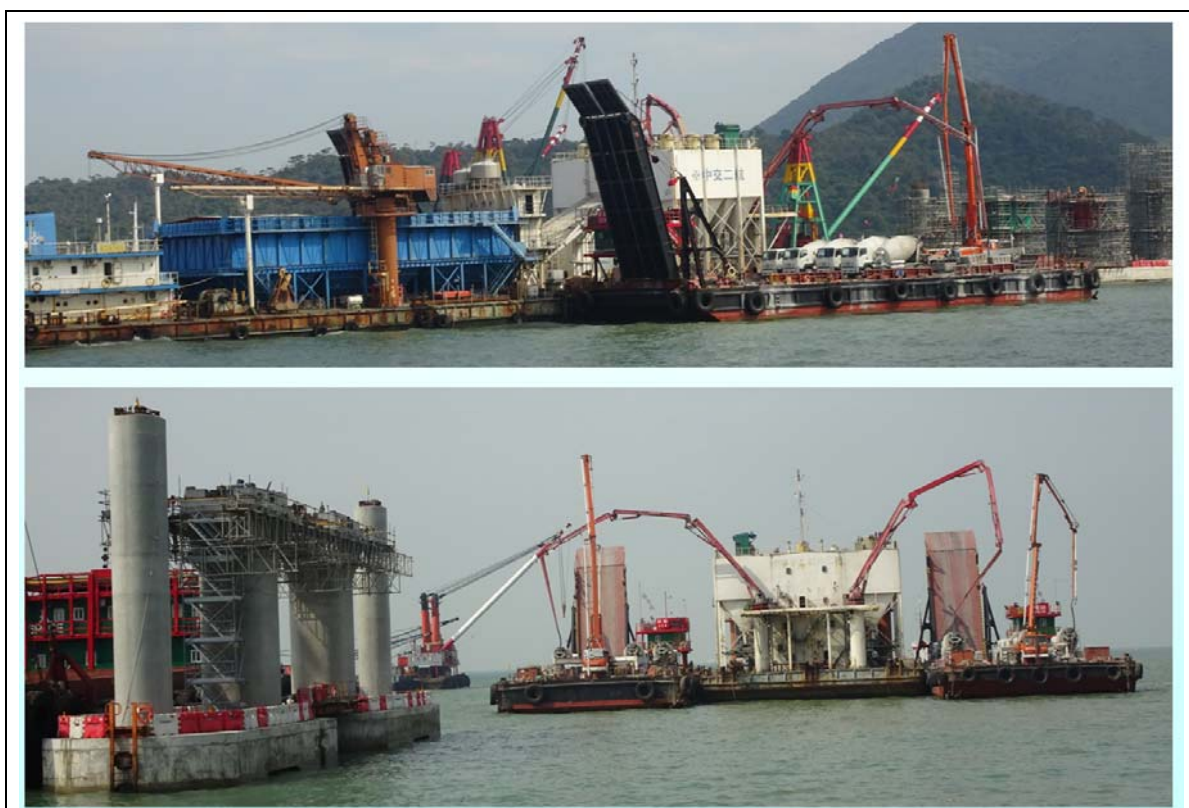
圖 4-13 香港連接線-跨海段施工(平台船載運預拌車海上澆置混凝土)
