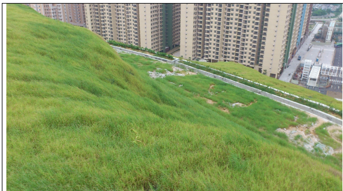
圖 5-7 石排灣斜坡加固以 GeoFiber 工法完成岩壁加固與綠化
