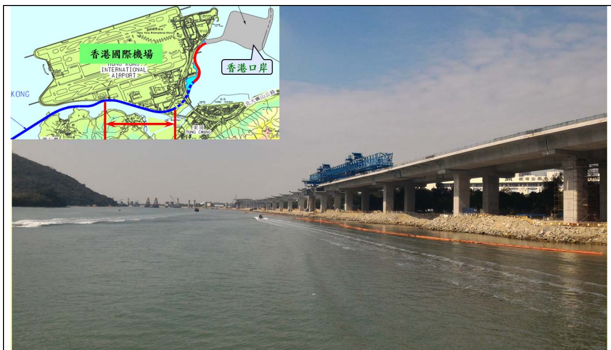
圖 4-7 香港連接線-沿赤鱸角機場段橋梁施工(1)
