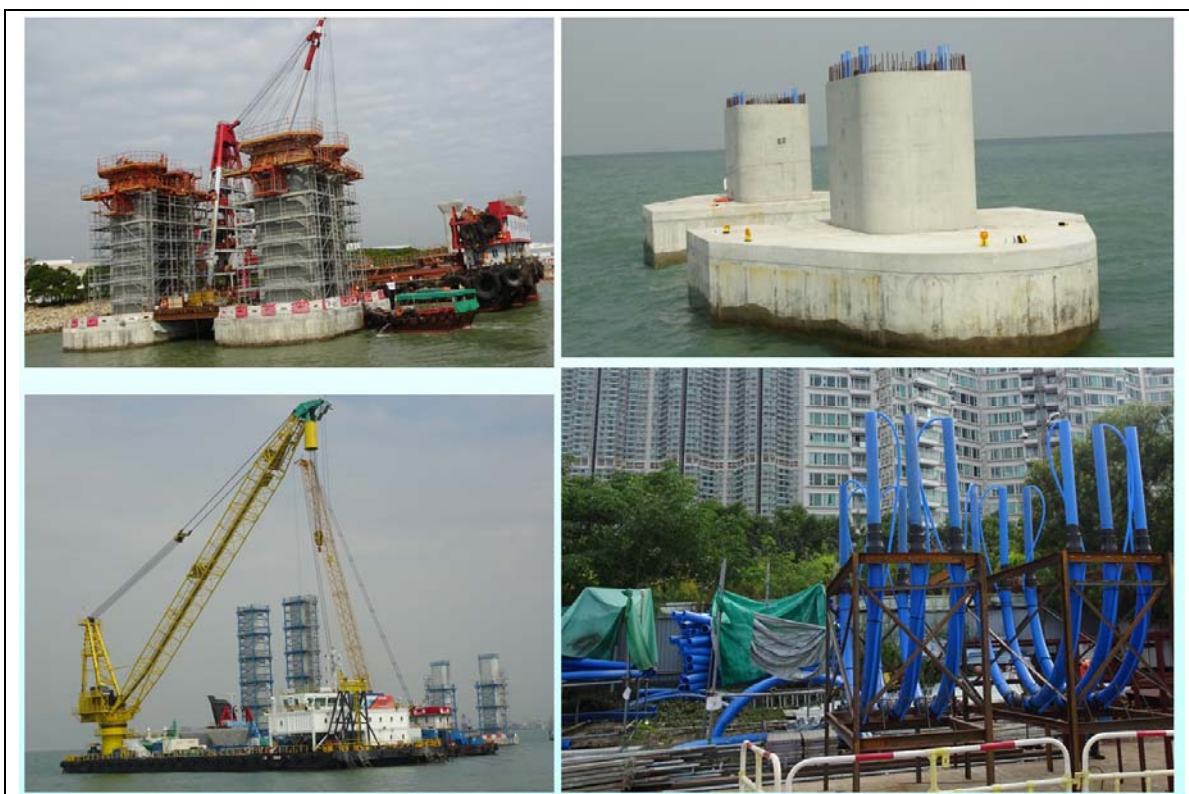
圖 4-14 香港連接線-跨海段 橋墩柱構造
