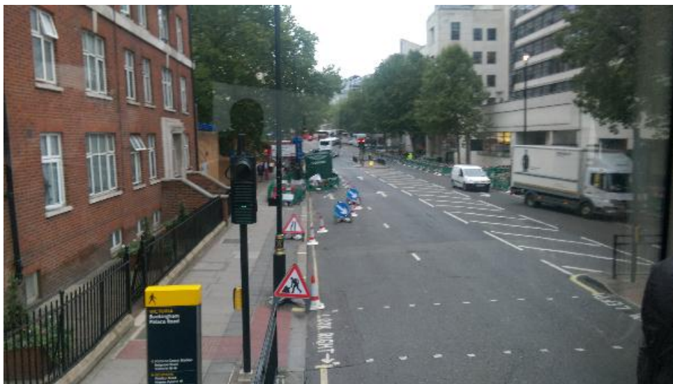
圖 62 英國倫敦市區路邊施工交維布設
