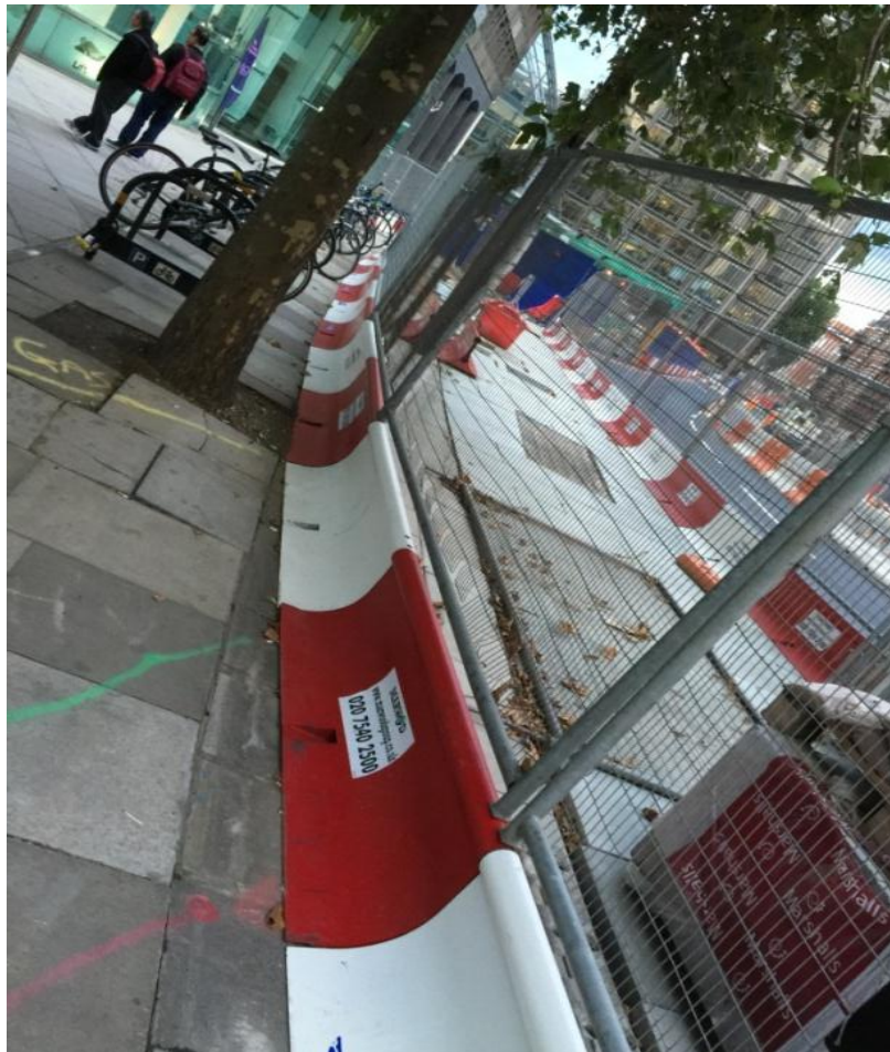
圖 65 英國倫敦市區施工使用鋼板護欄
