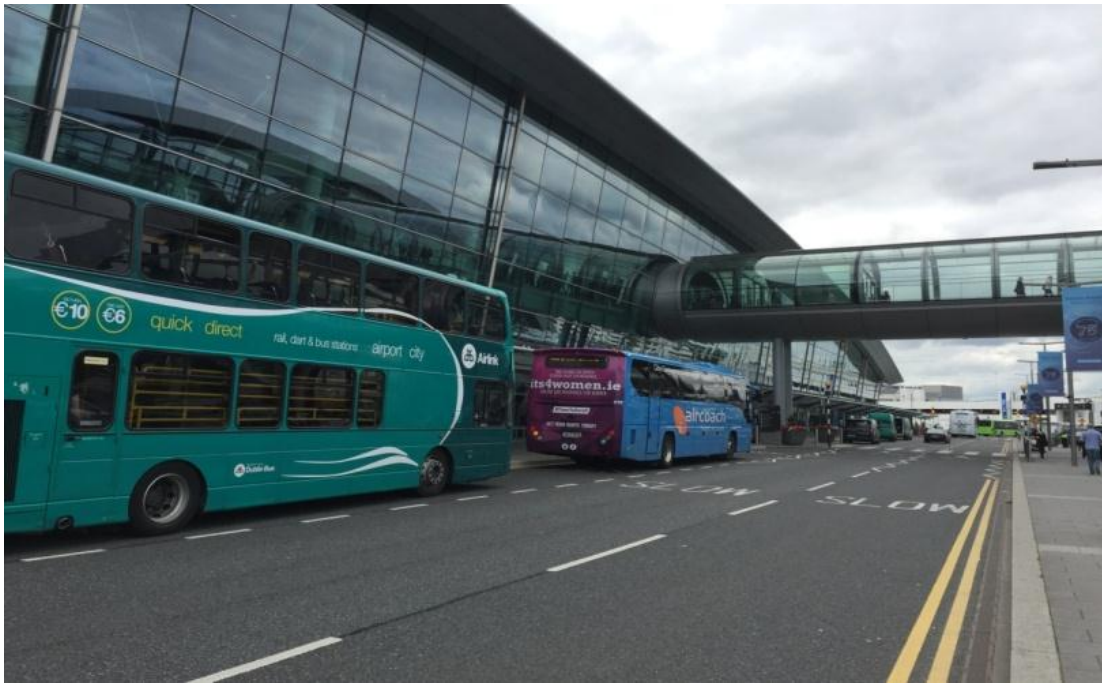
圖 70 機場道路於路口設置扭曲標線提醒注意減速及禁止停車
