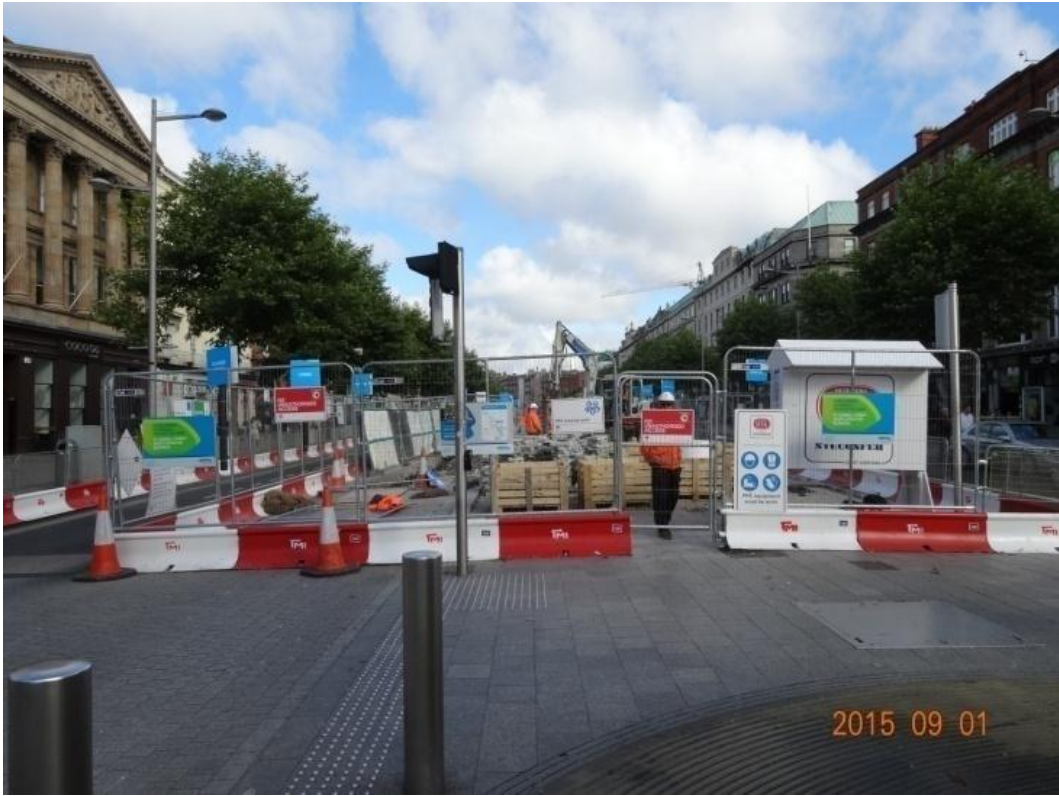
圖 64 愛爾蘭都柏林施工使用鋼板護欄
