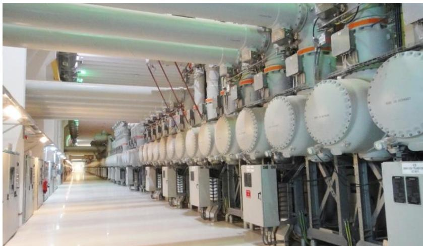
圖 42、PP10 燃氣複循環發電廠開關廠 GIS 設備
