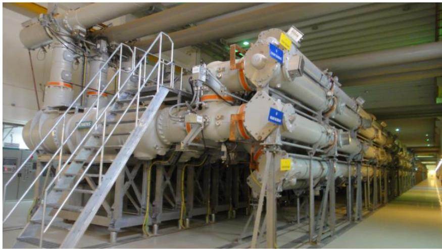
圖 41、PP10 燃氣複循環發電廠開關廠 GIS 設備
