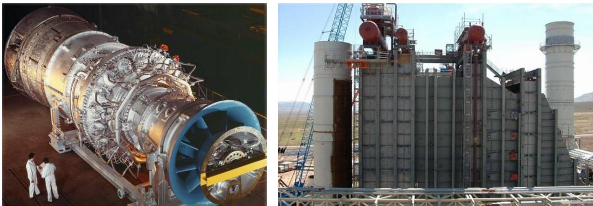
圖 34、PP10 燃氣複循環發電廠採用 GE 氣渦輪機與廢熱鍋爐
