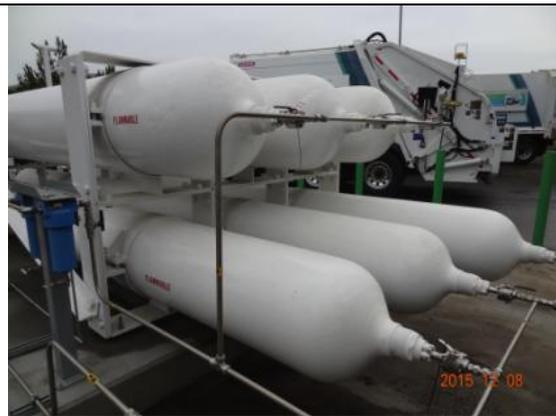
圖 45、儲氣鋼瓶，有 5 罐是設備產生的 CNG，1 罐是州內的天然氣管線引入，混合後供給清運車使用。由於設施的 CNG 產量仍不足以供給所有車輛，才採取如此做法，混和後的氣體品質仍然很好，無安全疑慮。
