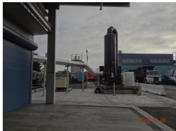
圖 43、設備連接空氣污染處理設備(黑色處)，降低 NOx。
