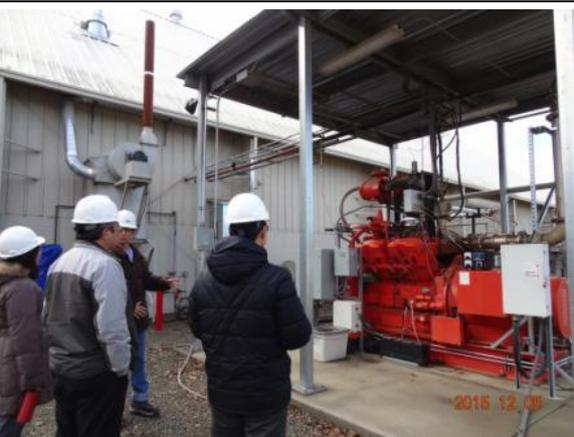
圖 36、氣的部分將送至這個 CHP 設備發電用，該設備由 West Biofuels 買回二手品組裝而成
