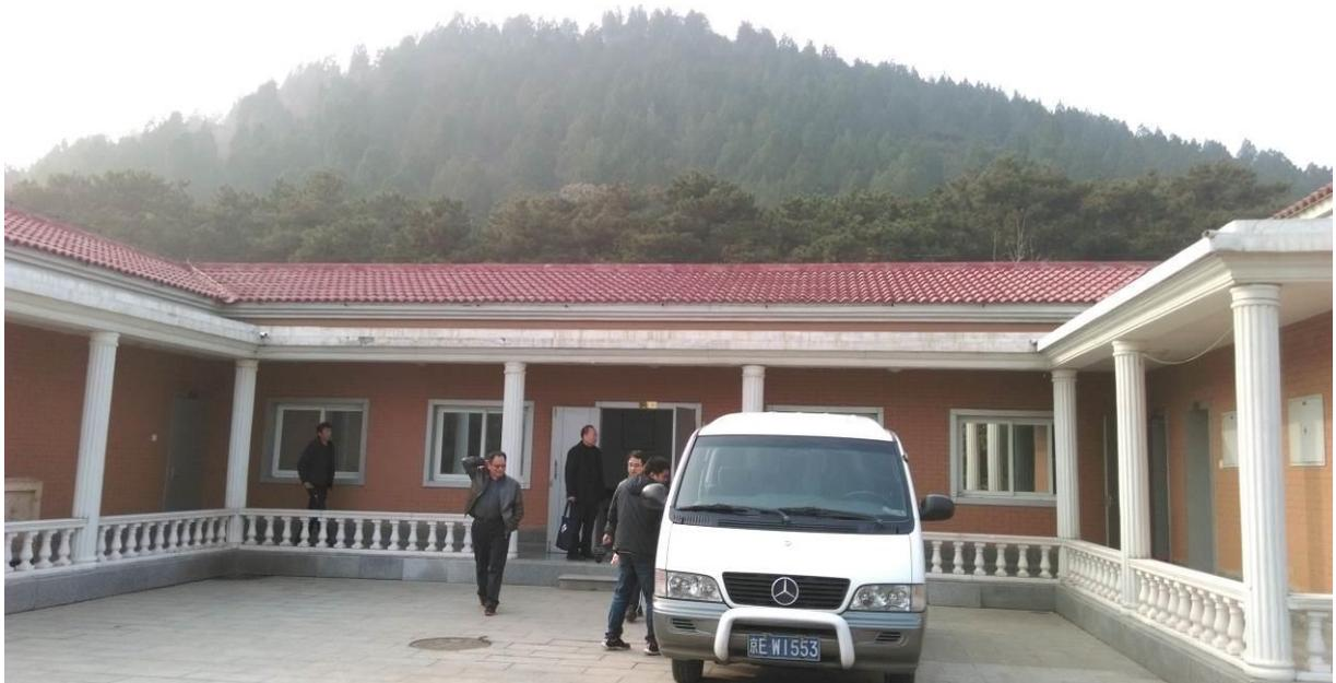
照片 40、十三陵地震台之地震儀器室獨立建置於自由土地場上，與辦公室保持距離以避免人為雜訊，全球衛星定位系統 GNSS 建置於山頂，以確保良好的透空度與記錄品質。
