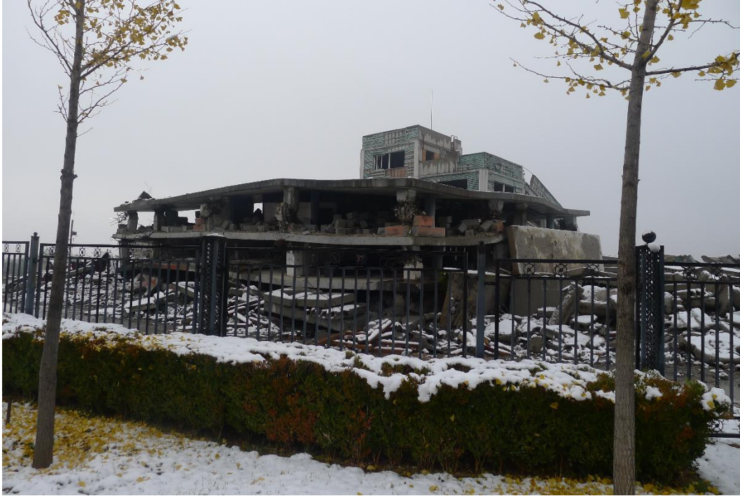
照片三十六、中國國家地震緊急救援訓練基地之樓板塌陷救災訓練場地
