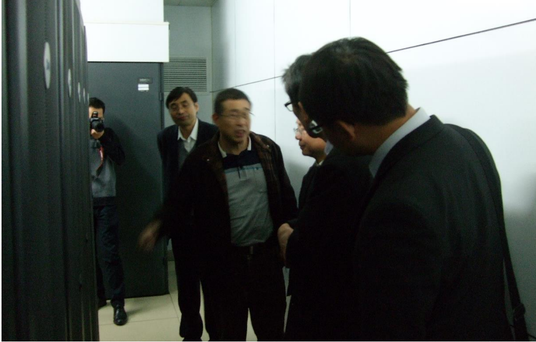
照片二十三、參觀中國地震局地震預測研究所機房設備。
