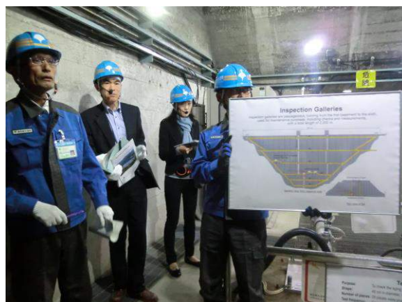
小河內水庫內部結構介紹
