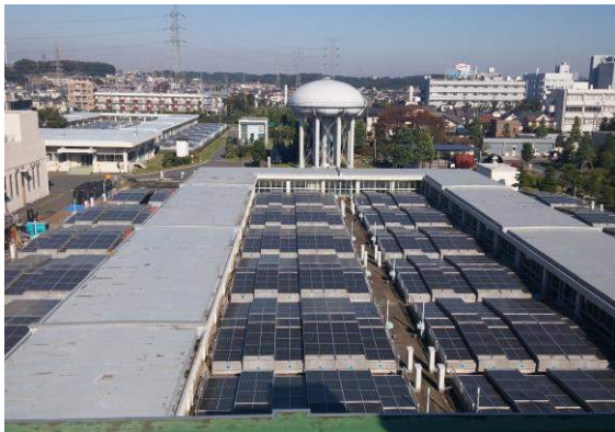
俯瞰東村山淨水場
