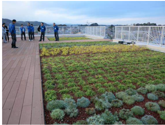
羽村取水堰展示廳屋頂之綠化具有隔熱降溫之效果
