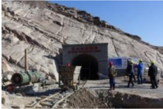
圖 23、坑探設施入口(左為抽風設備，中央為軌道輸送台車)
