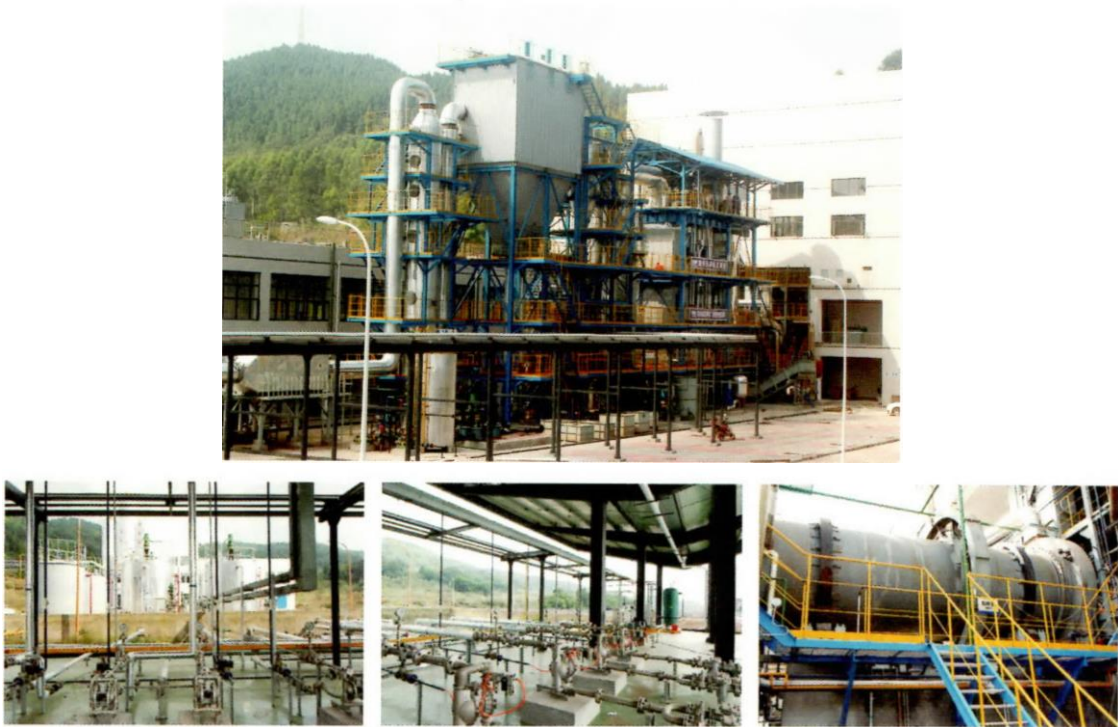
圖 2 焚化處理系統
