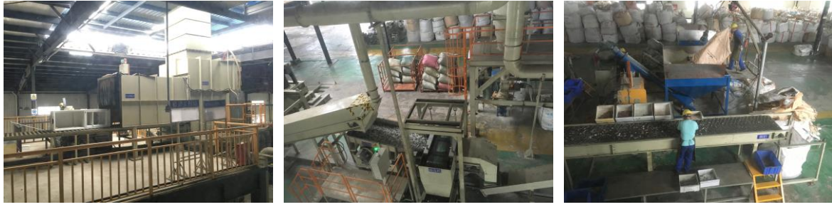
圖 7 廢冰箱拆解現況
