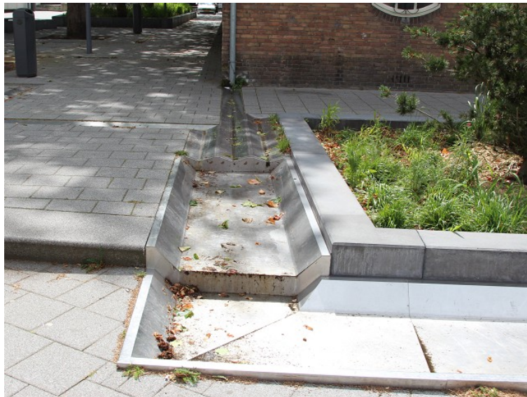
照片 25 引入水廣場之排水溝
