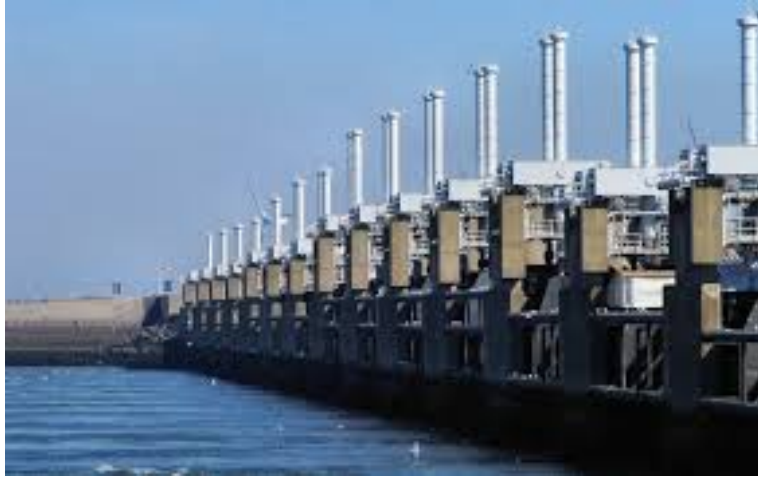
照片 8 荷蘭三角洲水閘門
