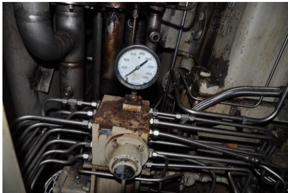
燃料油管路需拆卸數隻檢油垢情形
