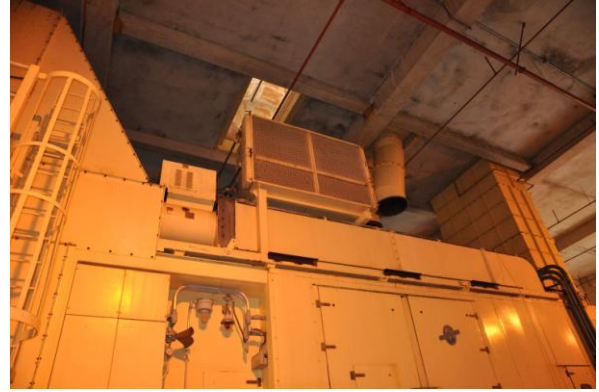
Macheche 電廠無冷卻水塔，為氣冷式，空氣熱交換器置於渦輪機屋頂
