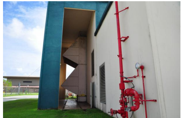
進氣室外圍鋼板結構，進氣室有良好的遮蔽
