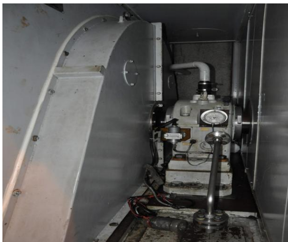
潤滑油系統需更換新油，並進行油洗作業
