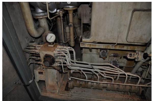
燃料油管路需拆卸數隻檢查油垢附著情形
