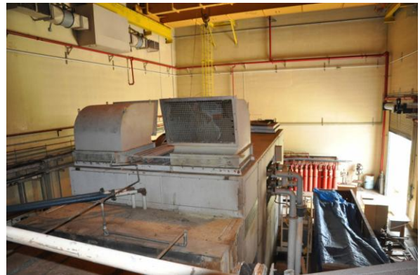
渦輪機圍體屋頂無銹蝕
