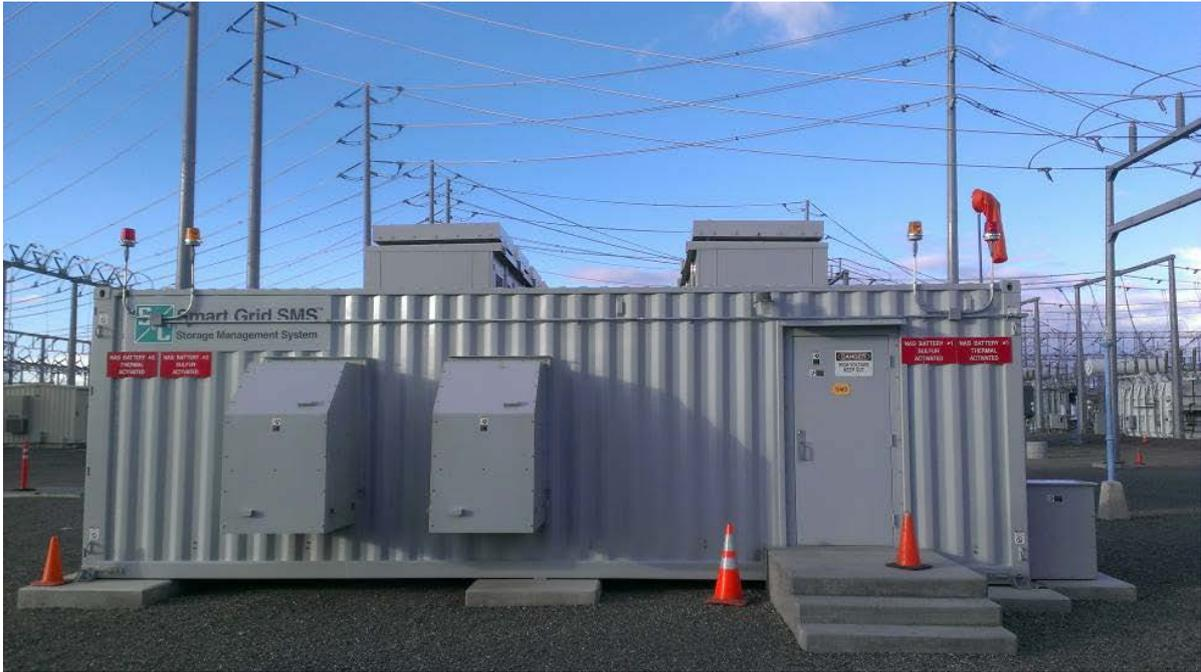
圖 24 NaS BESS 儲能系統管理系統
