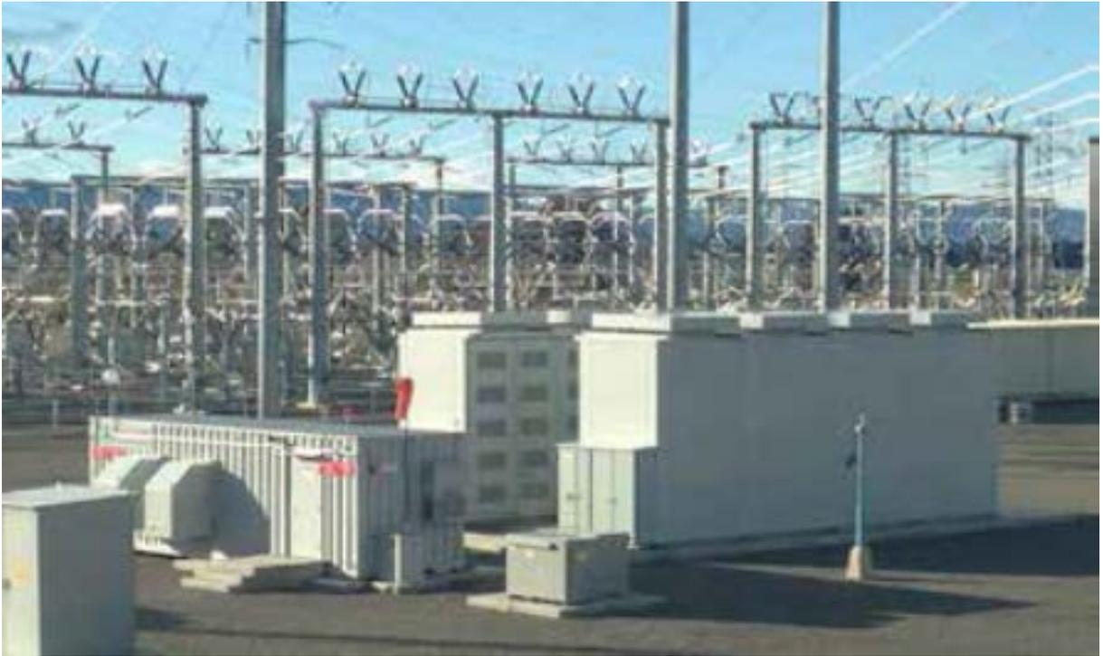
圖 22 PG&E 位於 Vaca-Dixo 變電所的鈉硫 BESS 儲能系統整體外型
