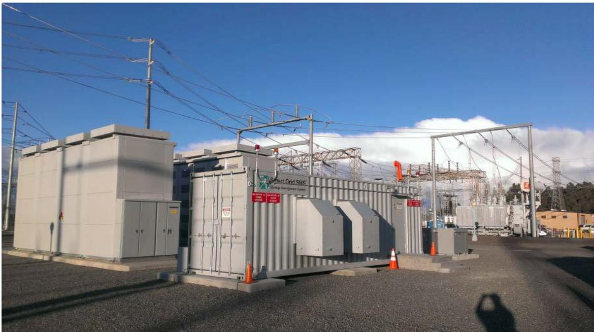
圖 23 容量 2 MW NaS 電池儲能系統 (Vaca-Dixon)
