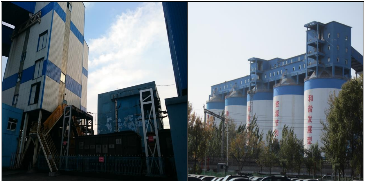
火車裝車站(左圖)、儲煤倉(右圖)
