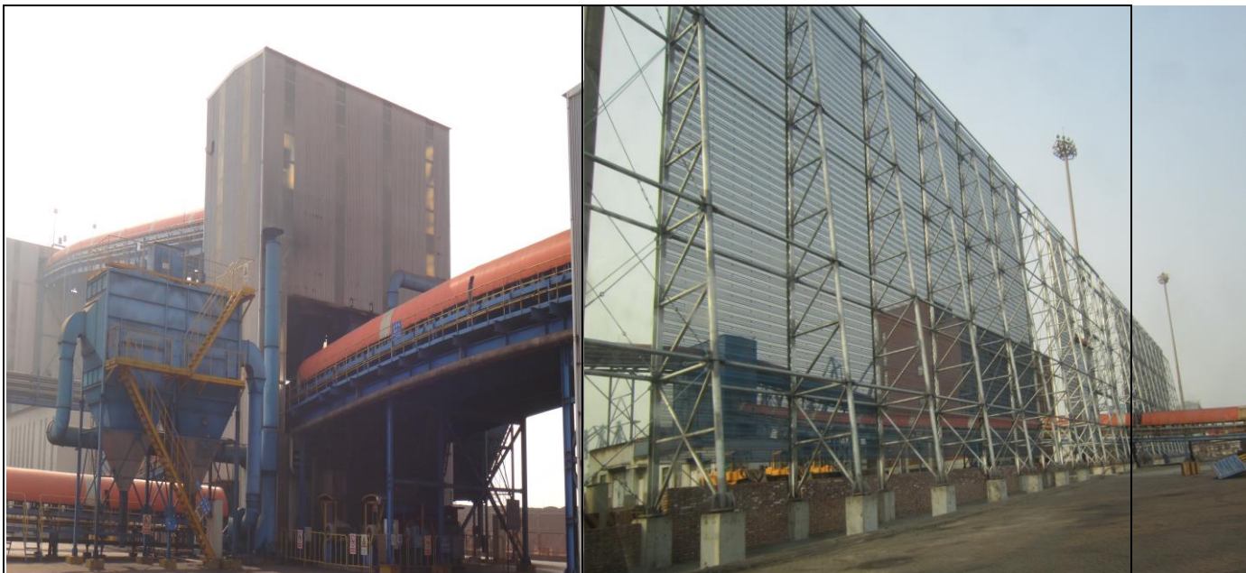
除鐵塔(左圖)、搭建中的防風柵網(右圖)
