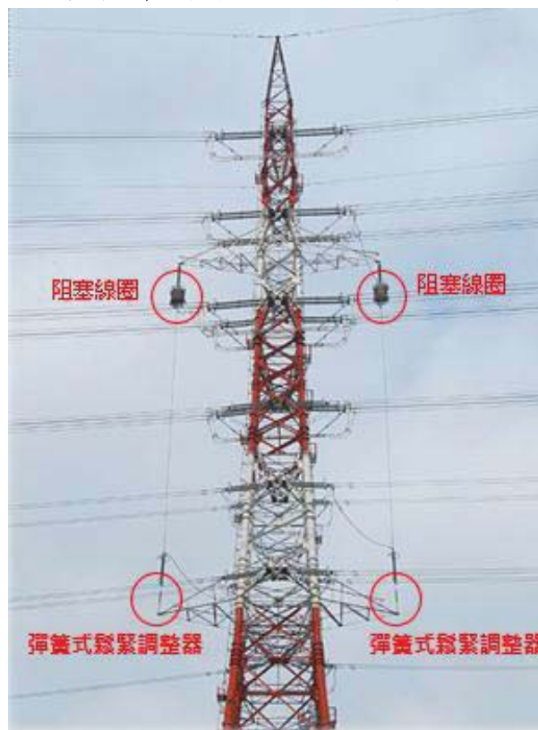
圖 20 阻塞線圈引入裝置
