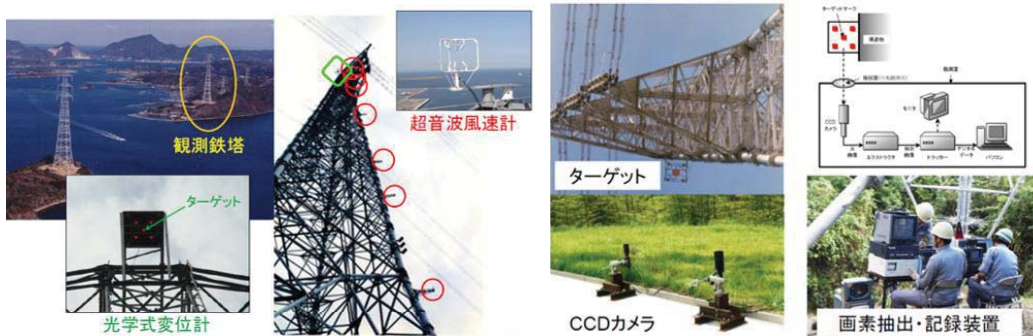
圖 34 觀測儀器安裝實照
