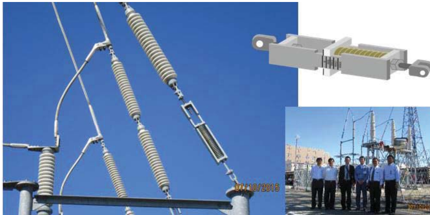
圖 16 彈簧式鬆緊調整器近照
