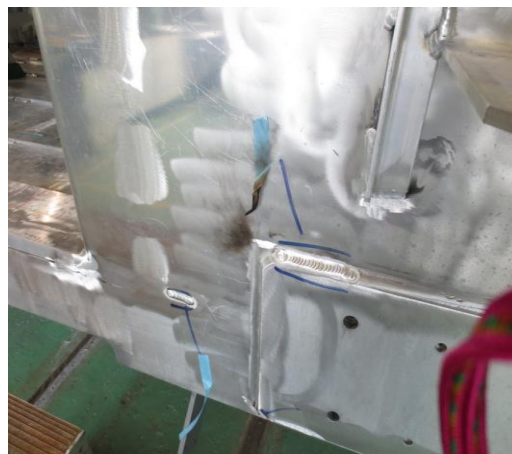
圖 2-43 焊道凹陷補焊及整修磨平-2
