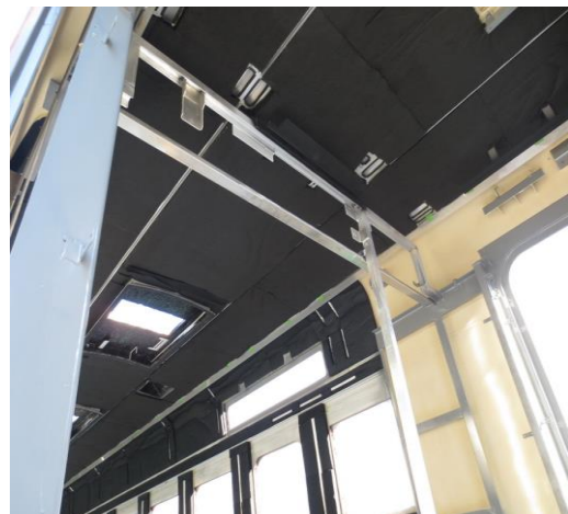
圖 2-52 車體內裝噴隔音漆及貼隔熱材
