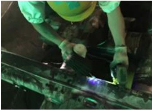
圖 2-35 焊接處進行磁粉探傷檢驗
