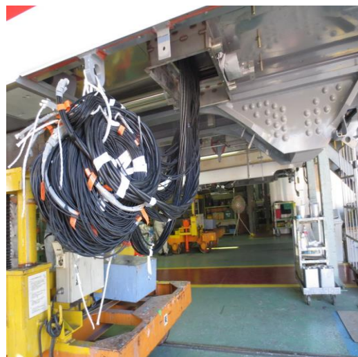
圖 2-64 車底配線安裝作業
