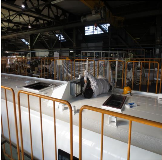
圖 2-65 車頂風管安裝作業
