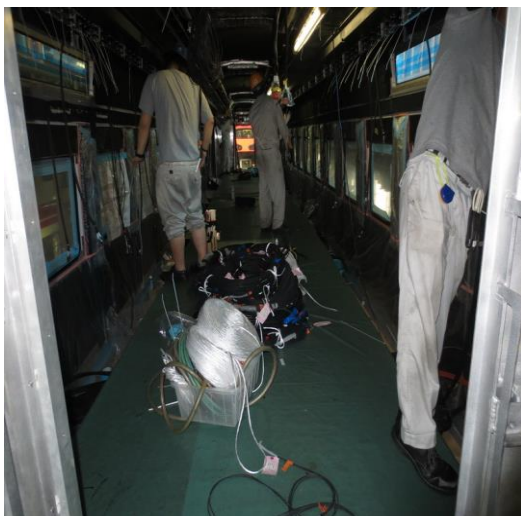
圖 2-63 車廂內配線安裝作業
