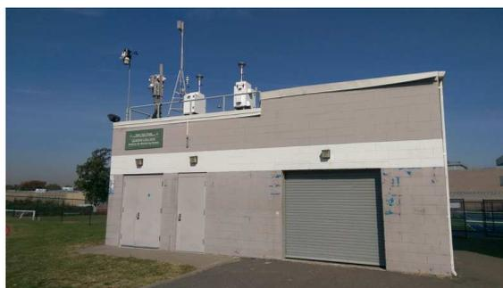
USEPA Region 2 負責在紐約州的 5 個 N-Core 型測站之一)，除一般大氣污染物監測儀外，國家級核心測站多備有超細微粒計數器及高精密性（trace level）氣狀分析儀（SO<sub>2</sub>, CO, nitrogen oxides (NO/NO<sub>2</sub>/NO<sub>y</sub>））及成分監測儀器（speciated PM<sub>2.5</sub>, PM<sub>10-2.5</sub>），並整合 PAMS O<sub>3</sub> 前驅物監測及毒化污染物監測(NATTS sites)等，以提供更精準的監測資訊以利健康研究與空氣品質標準訂定參考。儀器主要由聯邦環保署統一採購設置（主要以 Thermo 廠牌為主），委由紐約州環保單位執行操作維護。設備的確
