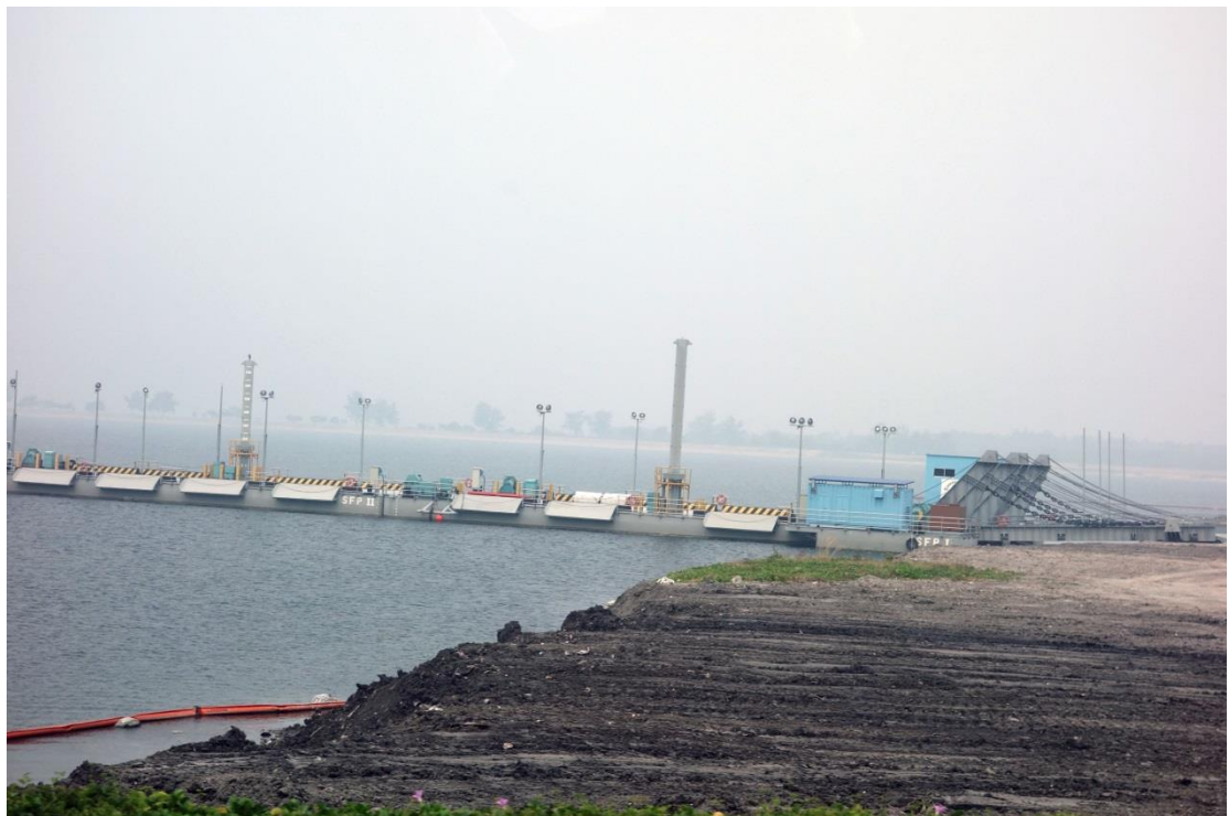
圖 29 浮動平臺自堤岸延伸示意圖
