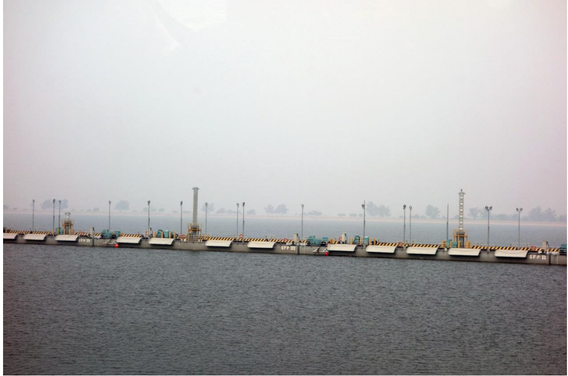
圖 28 第 2 期工程浮動平臺
