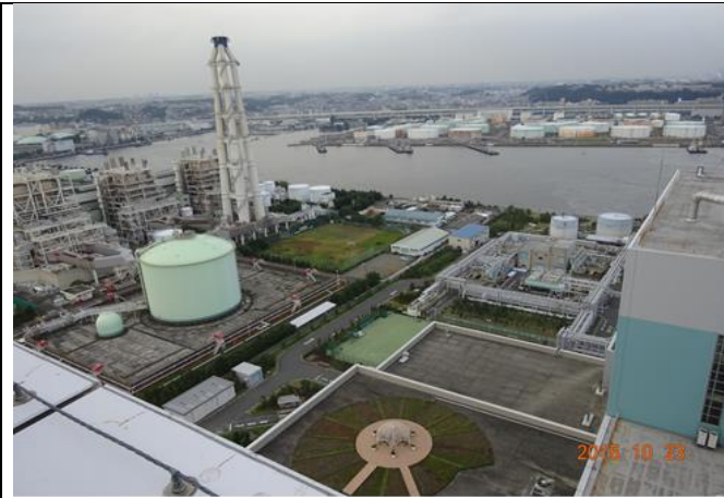
圖 7.日本電源開發(J-POWER)礪子火力發電廠
