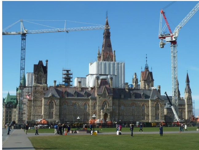
圖2.8 國會山莊西區建物及維護施工情形
