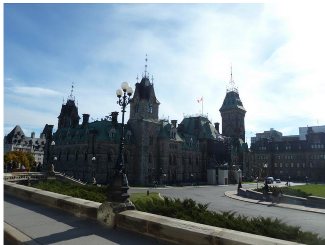
圖2.9 國會山莊東區建物及維護施工情形
