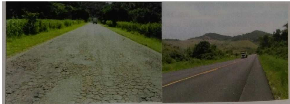
圖 2 RJ 122 公路鋪設 ARFC 結構橡膠瀝青混凝土鋪面
