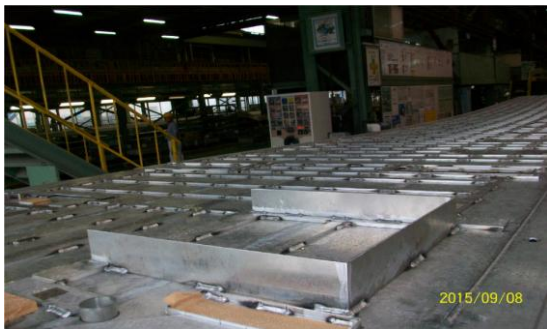
圖 3-10 鋪設床板完成
