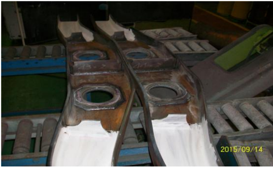
圖 3-42 內部補強焊接
