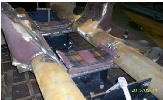
圖 3-52 橫樑架框焊接
