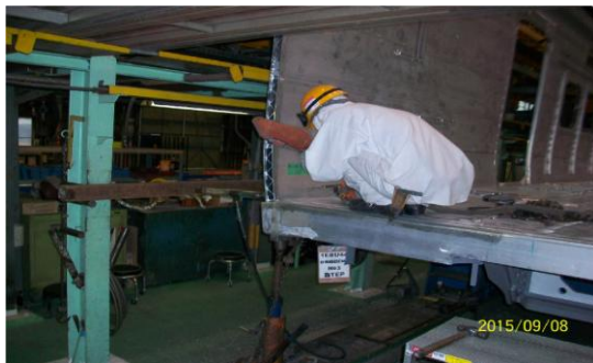
圖 3-35 車體接合處焊接
