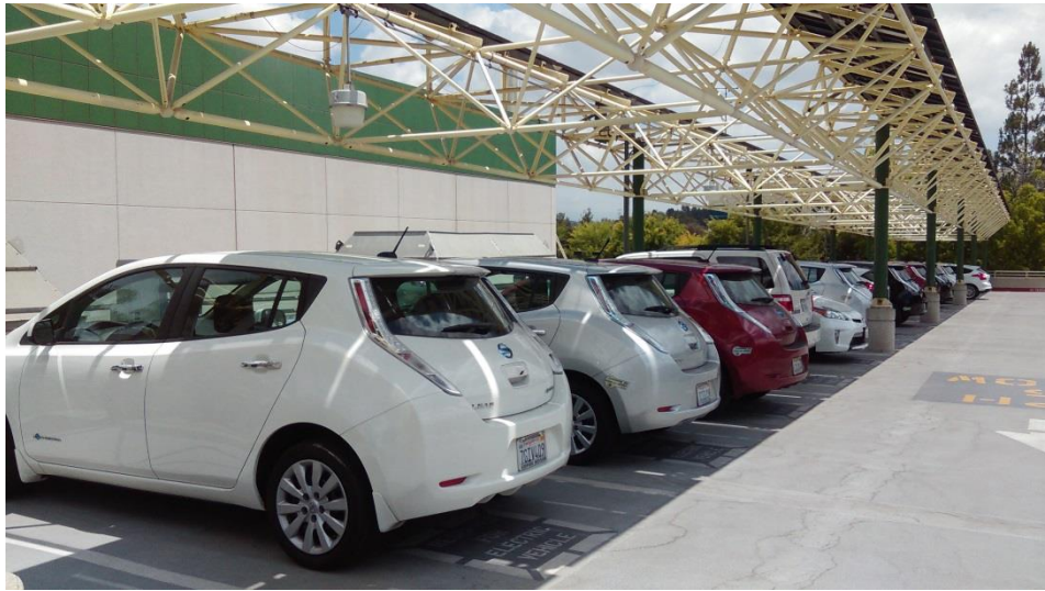
圖 7.5 南加州空氣品質管理局(SCAQMD) 停車場之免費充電站，其電力來源為棚架上的太陽能板
