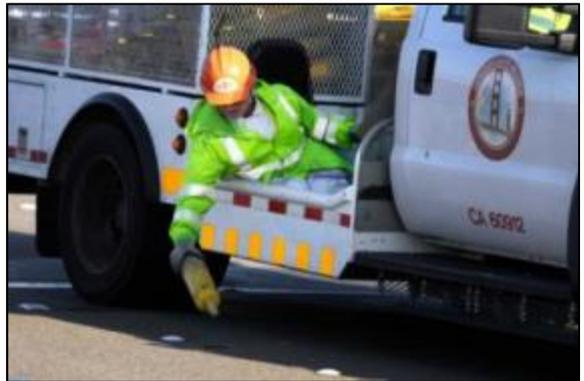
圖 2.2.3.2-7 金門大橋車道調撥－人工移動往復式導桿作業
