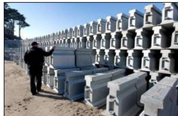
圖 2.2.3.2-8 金門大橋護(隔)欄移動車(底部)及預製樺接式護欄
