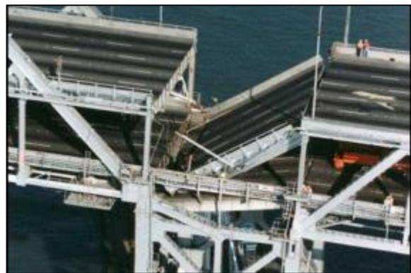
圖 2.2.3.1-3 1986 年地震橋損情形
