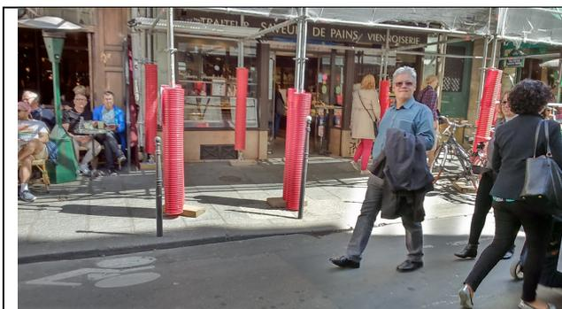
圖 9 人行道上的施工架，在與人體有接觸之虞的高度，包套塑膠軟墊
