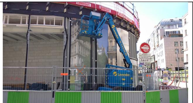
圖 8 高空工作車路邊停放時，也作好適當人員隔離及防護
