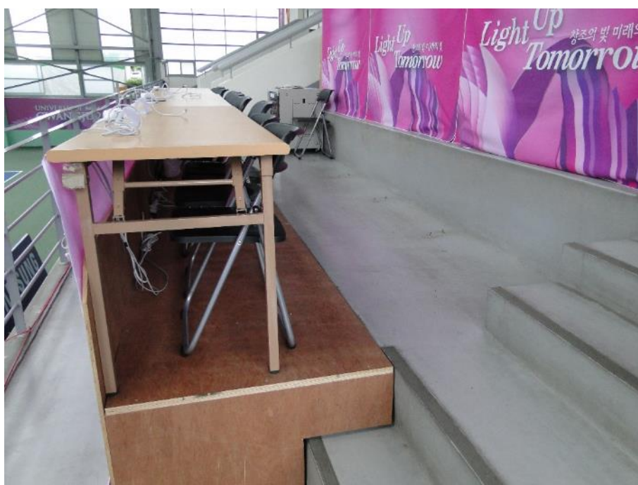
圖 媒體席（拆除現有觀眾椅，並以裝潢方式裝設）
