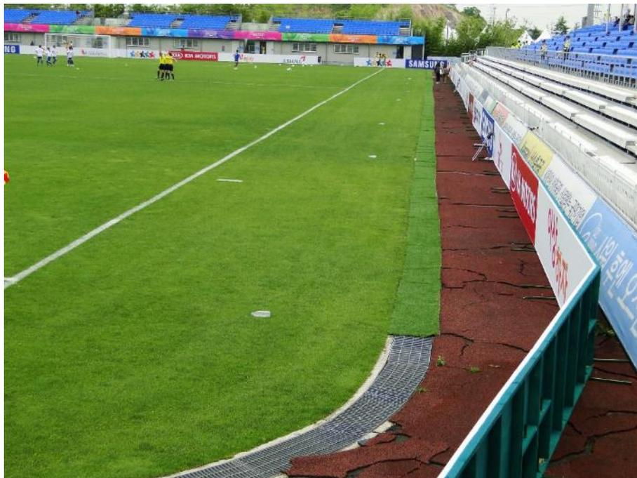
圖 既有地板面層龜裂未修繕、部分排水溝鋪人工草皮保護
