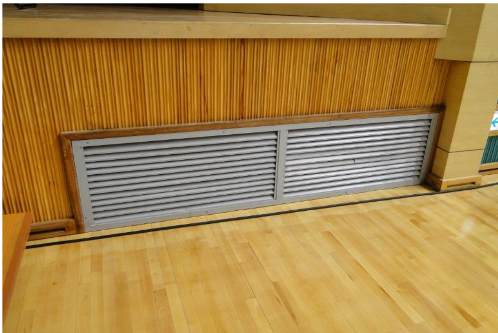
圖 球場出風口設置於底端
