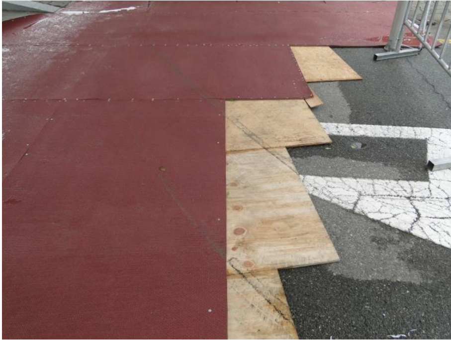
圖 暖身場前往競賽場地通道以夾板上鋪橡膠面層施作
