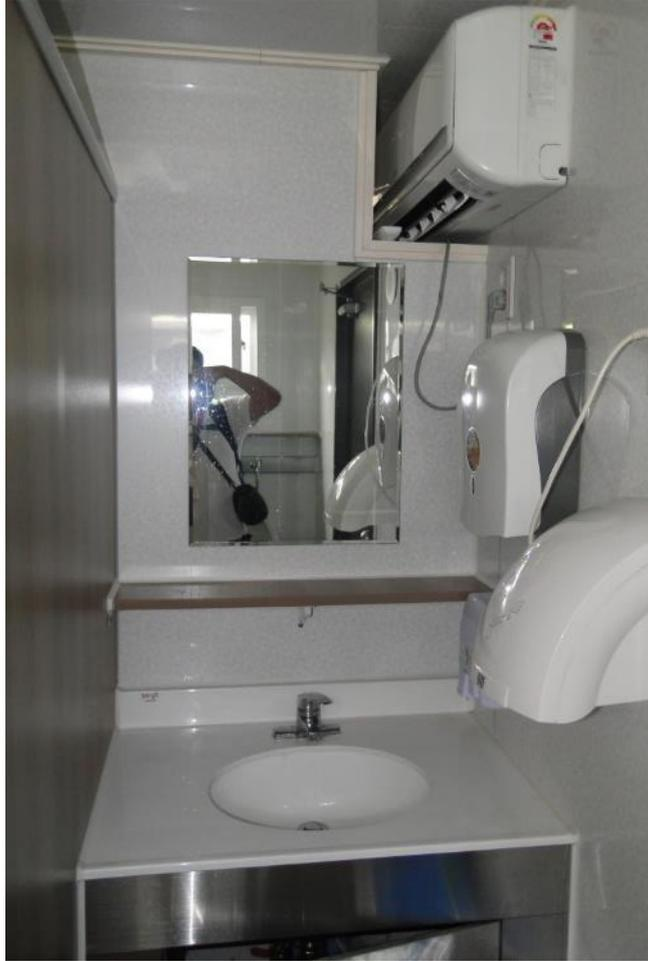
圖 臨時洗手間內之洗手臺、洗手乳、烘手機及分離式冷氣。
