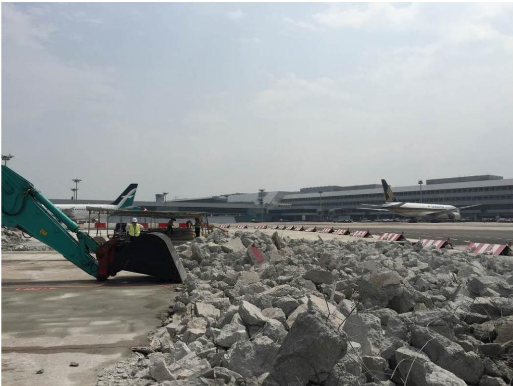
正在將舊鋪面挖除，再將所挖下來的材料送進篩選室，留下可再利用的材料，新的鋪面材料中有50%是利用回收的材料。
