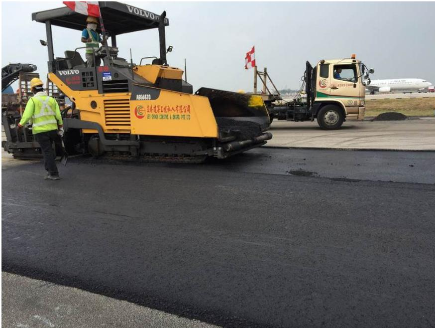
將瀝青混凝土鋪上道面，並壓平
