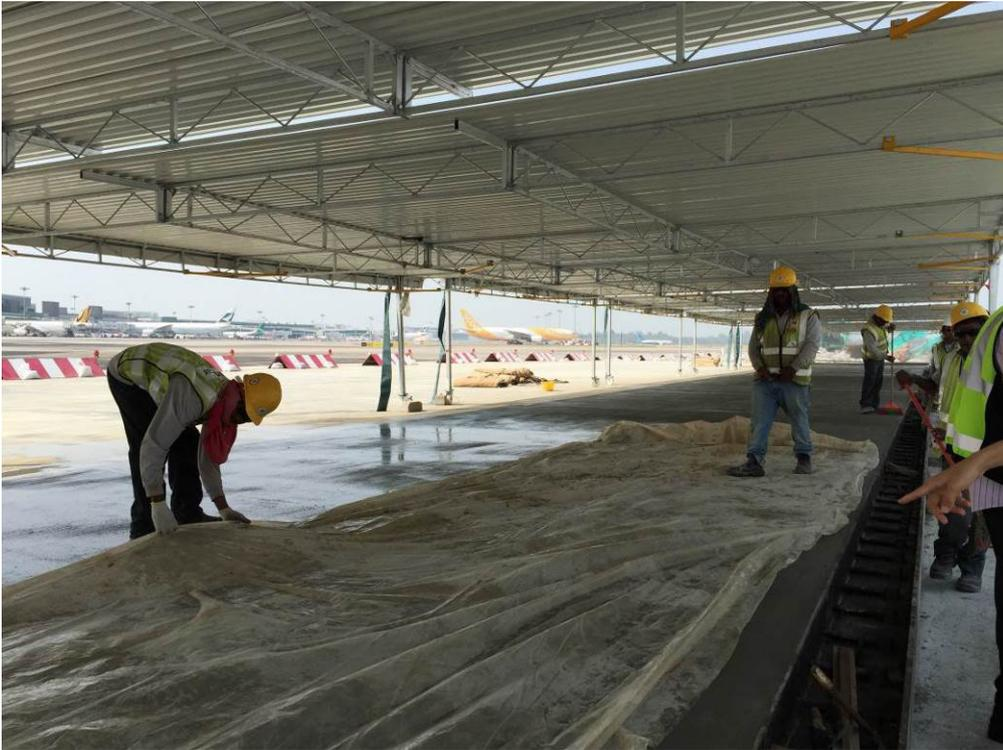
混凝土澆置完成後立即掃紋(防滑)及養護，以防風吹日曬而乾縮龜裂
