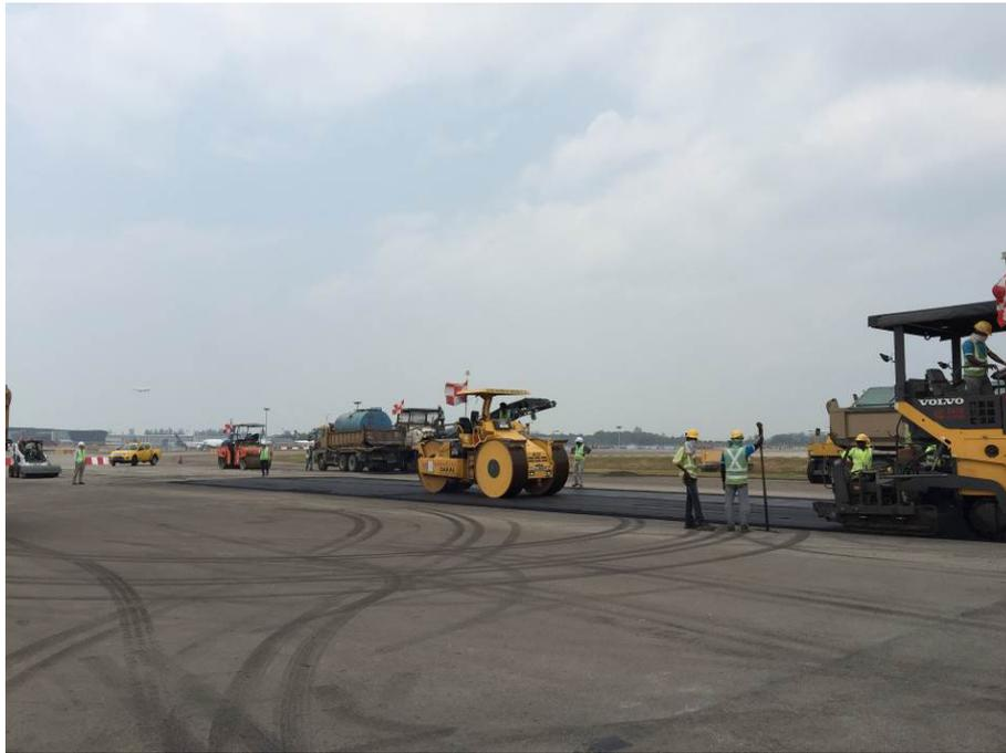
以光輪壓路機來回滾壓，並校正高度，不足處再補足及滾壓。
