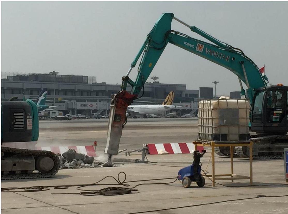
為避免挖除工程的煙灰瀰漫，在挖除的同時會利用灑水機器灑水。
