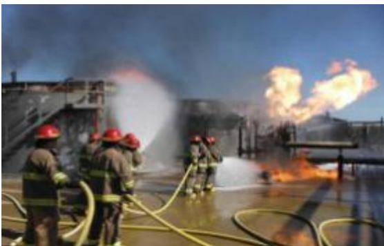
隔離儲槽火源，掩護進入關斷泵浦隔離閥
