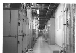
机械走廊 ( 走廊式机械室 )
