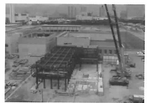
照片2 当时正在建设的尖端医疗中心(2001年9月)
