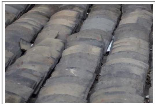
2005年重建的萬佛樓屋瓦多處破損
