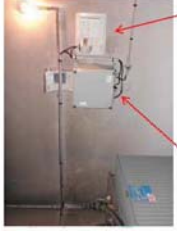
Le coffret PA IRIS Le concentrateur LINKY
