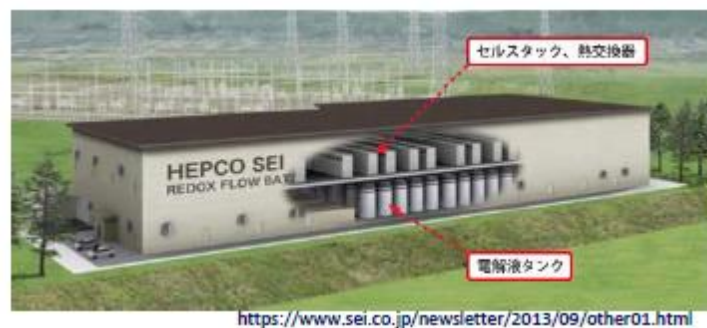
圖 7-24 60MWh Redox flow 儲能電池系統示範計畫
