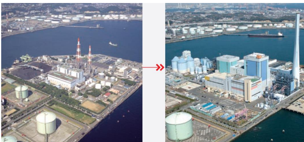
圖 4-2 磯子火力發電廠改建前後之外觀
