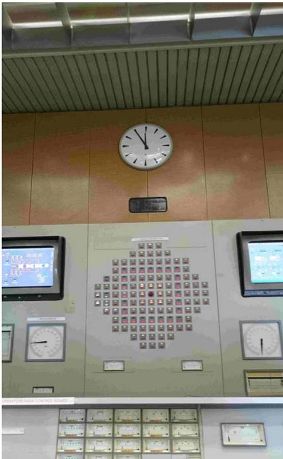
圖(13) 爐心監控盤面
