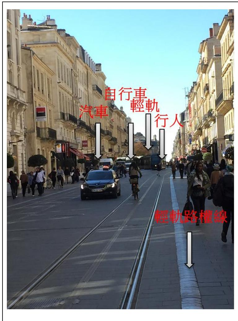
圖54 波爾多輕軌路權示意照片
