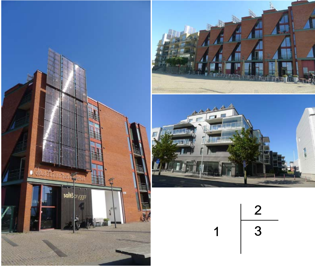
圖 8、馬爾摩太陽能熱、電系統 (1 設於建築物牆面太陽能光熱板；2、3 屋頂太陽能光電板)
