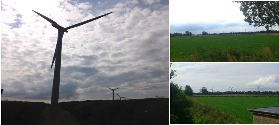
圖 49、大型風力發電機組
