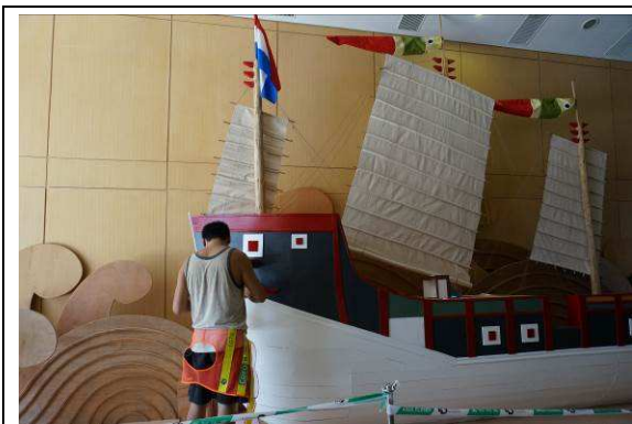
圖 9 展場木作施工
