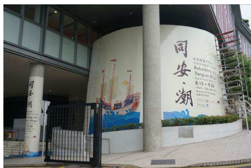
圖 41 外牆及柱子完成施工
