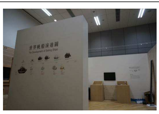
圖 6 展場木作施工
