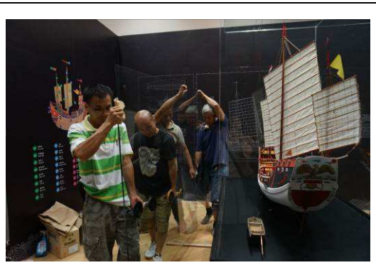
圖 28 模型船玻璃櫃安裝
