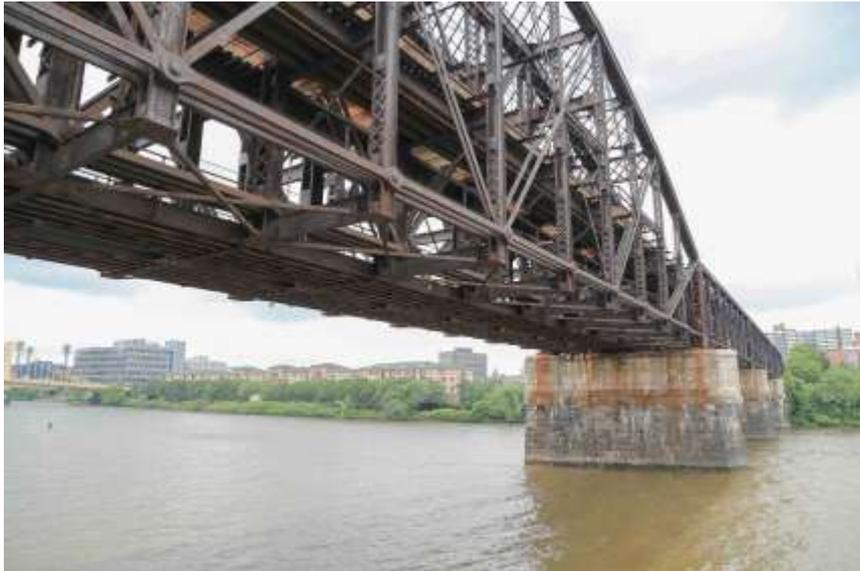
照片4-8 使用耐候鋼材之鋼橋
