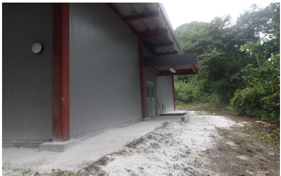
圖 4、SPF 胚蛋生產設施入口。牆面設有防鼠擋板，四週鋪灑石灰，石灰定期於每周及雨天過後進行鏟除更新。
