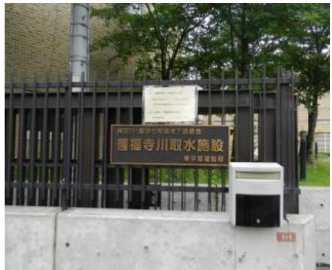
圖 74 善福寺川引流取水設施
