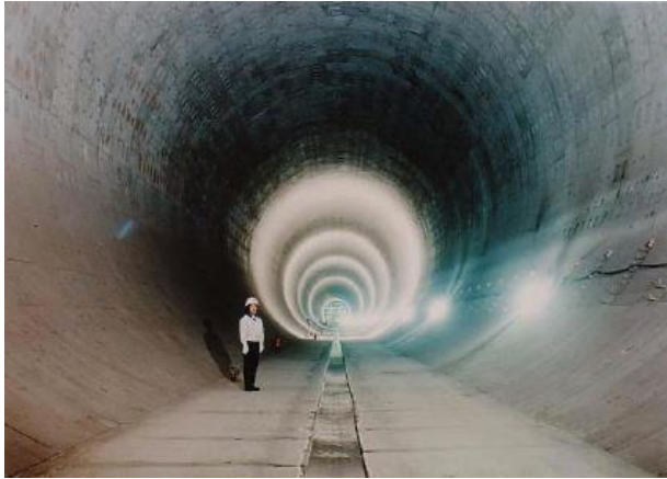
圖 71 地下滯洪隧道內的情形
