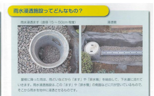
圖 63 雨水浸透管及入滲設施 (東京都下水道局)
