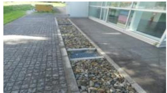
圖 61 柏校區內礫石入滲鋪面及排水口
