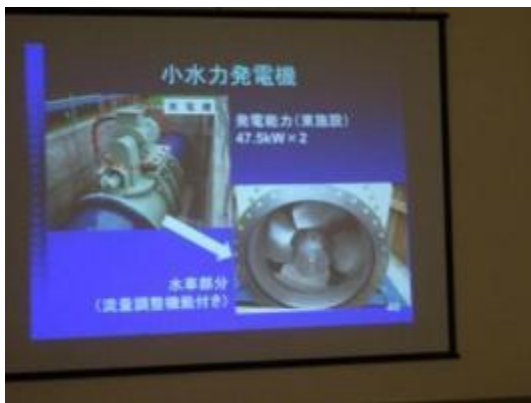
圖 39 森ヶ崎水再生中心設置小水力発電之發電機組
