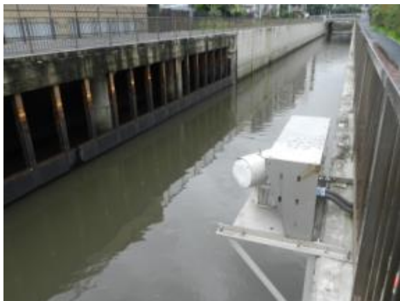
圖 75 善福寺川引流口固定堰
