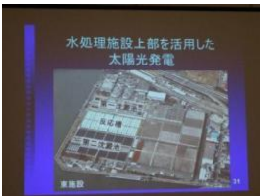
圖 35 森ヶ崎水再生中心水處理設施上部設置太陽能發電
