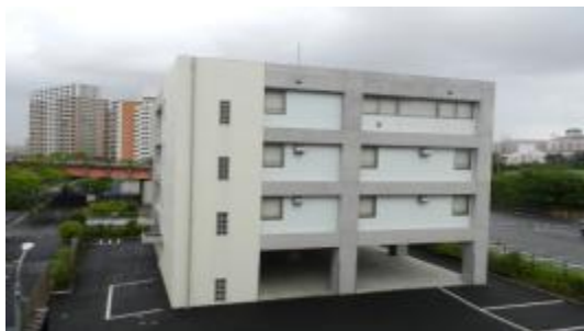
圖 89 堤防內建物留置洪水空間
