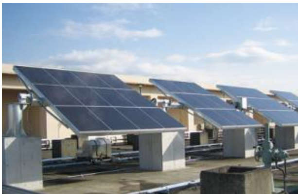
圖 31 單軸追日型太陽能板
