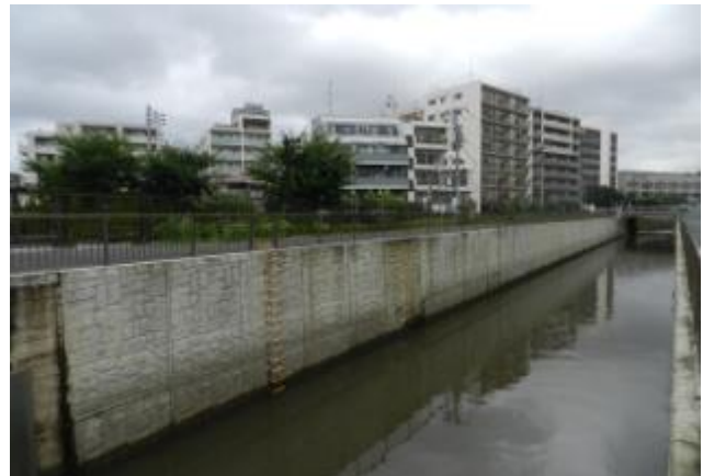
圖 76 善福寺川現況護岸
