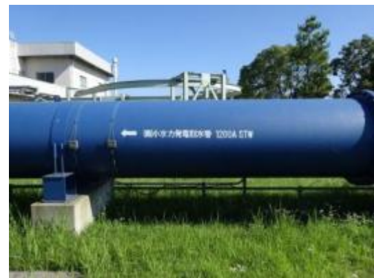
圖 40 森ヶ崎水再生中心設置小水力発電取水管
