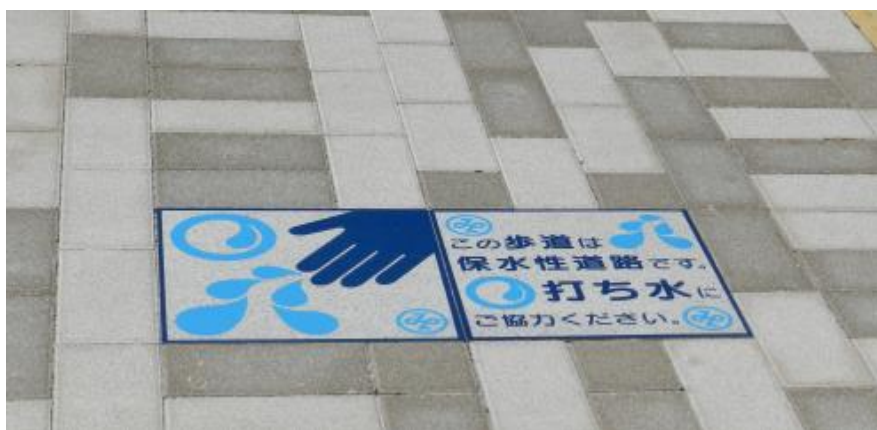
圖 16 芝浦中央公園旁步道採用透水性鋪面
