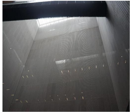
大廳壯觀的白紗帷幕區隔了大廳與各樓層的照明，亦具有消防防護區劃及防止觀眾墜落之功能
