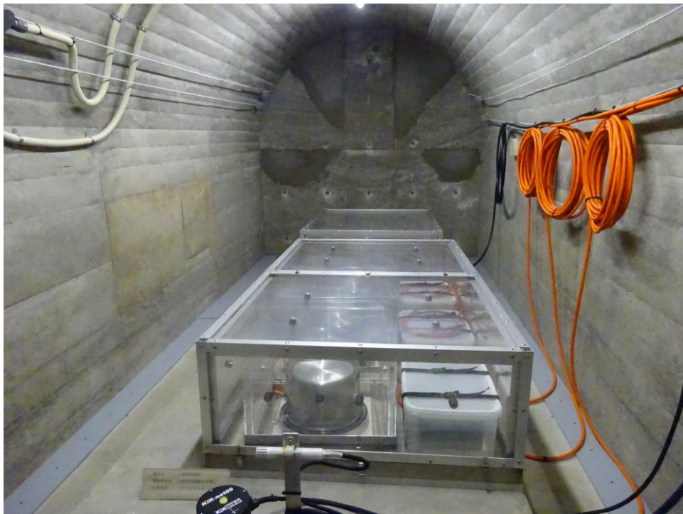
圖十三、筑波地震站山洞內儀器擺設情形。
