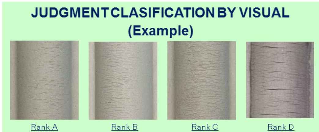
圖 18 判別熱疲勞與腐蝕破壞嚴重程度
