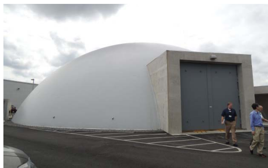
圖六、救援設備儲存設施建築物外觀
