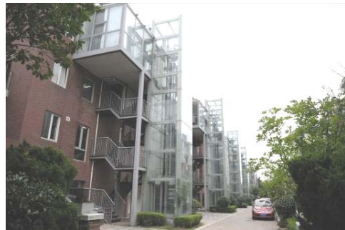
圖 30 中區低層住宅棟區
