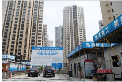
圖 72 濟南市住宅產業化試點工程現況
